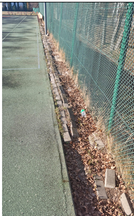
Fot. 2. Istniejąca opaska z kostki – ponowne ułożenie fragmentu opaski
