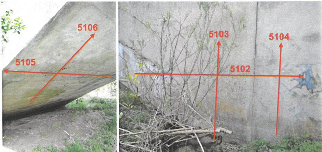
Fot. 12,13. Widok z lokalizacji wykonanych skanów zbrojenia – strona zachodnia.
