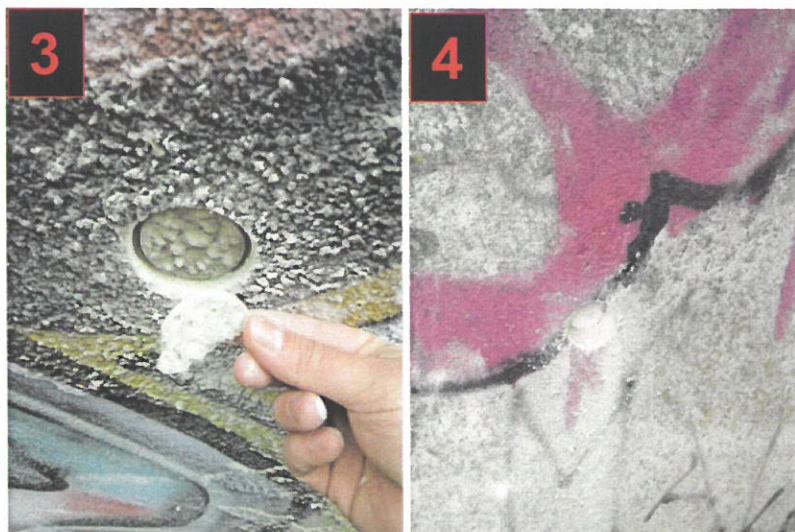
Fot. 18, 19. Widok z przykładowych pomiarów metodą pull-off.
