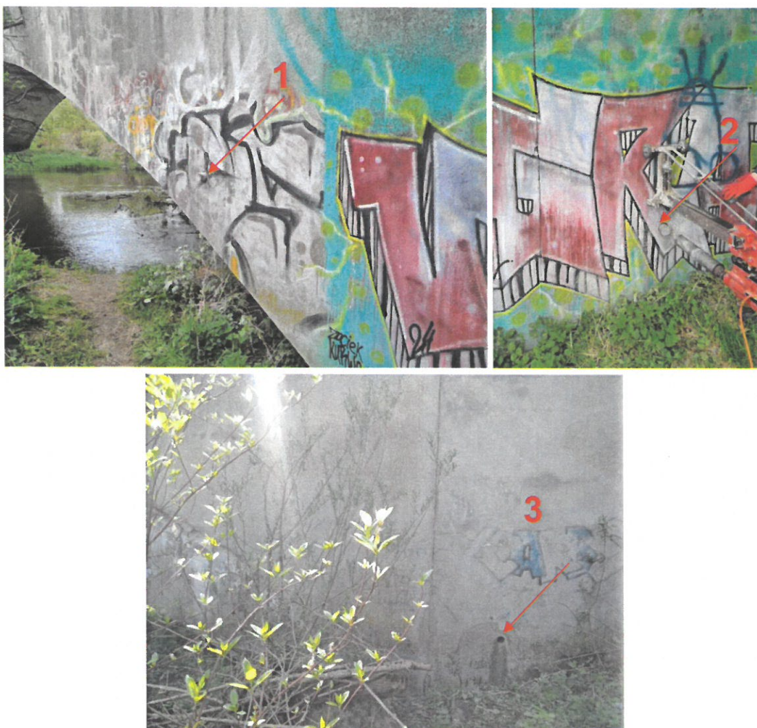
Fot. 4-6. Lokalizacja wykonanych odwiertów rdzeniowych.
