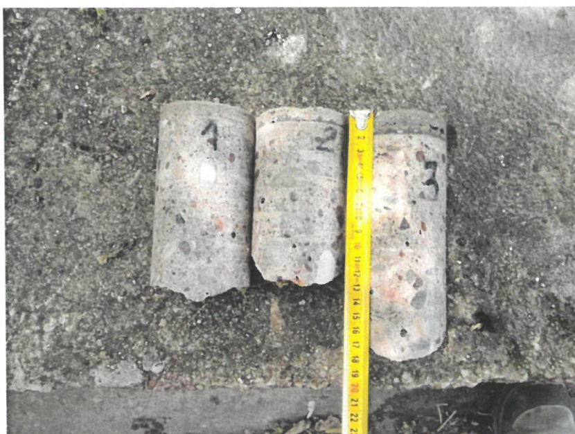
Fot. 7. Widok wykonanych odwiertów rdzeniowych.
