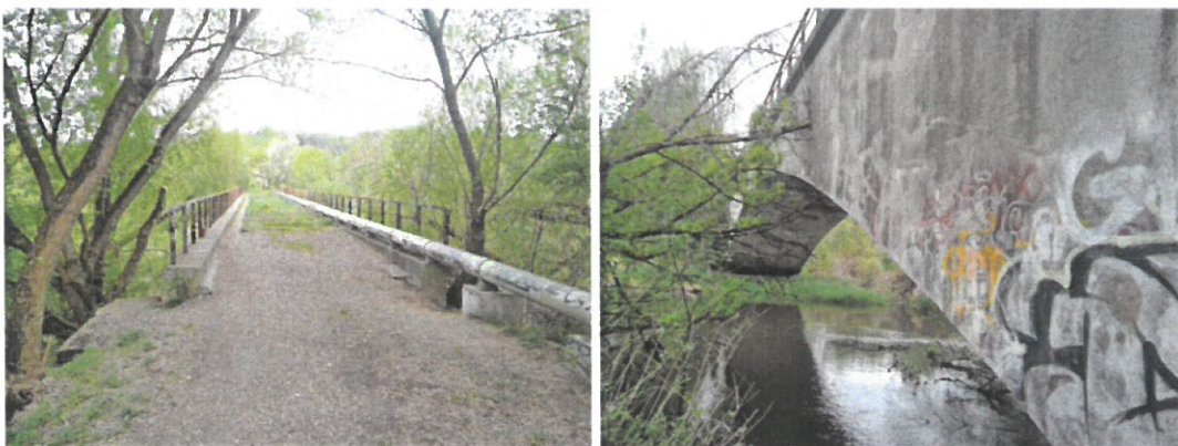
Fot. 2,3. Widok przedmiotowego obiektu.
