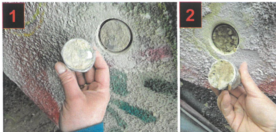
Fot. 16, 17. Widok z przykładowych pomiarów metodą pull-off.
