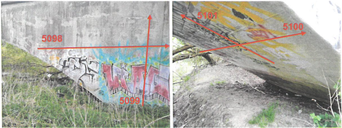
Fot. 10,11. Widok z lokalizacji wykonanych skanów zbrojenia – strona wschodnia.
