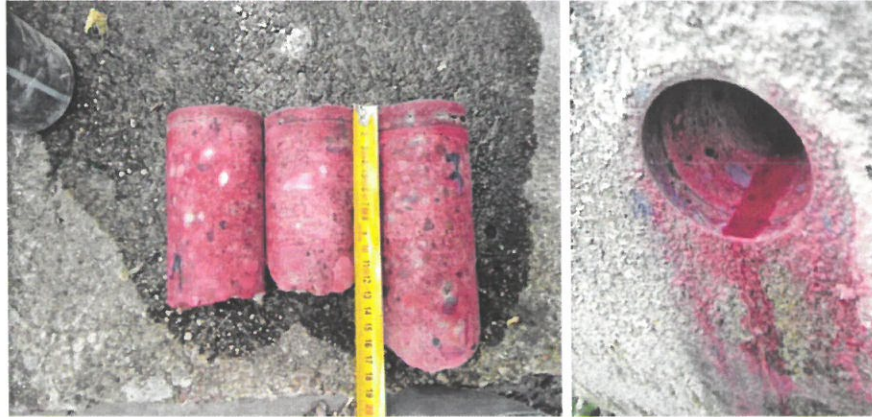
Fot. 14, 15. Pomiar karbonatyzacji na wykonanych odwiertach rdzeniowych.
