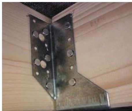
Łączenie za pomocą łączników ciesielskich
