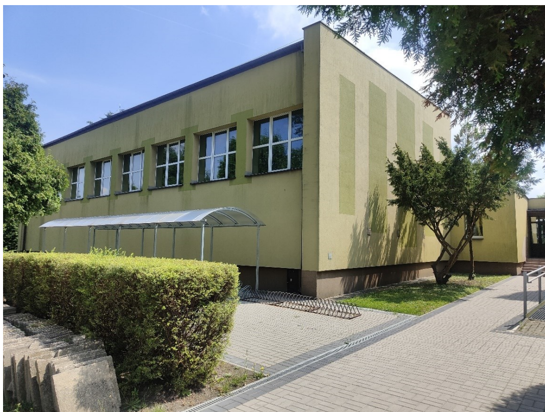
Fotografia 5. Widok szkoły od strony elewacji zachodniej – ujęcie 2
