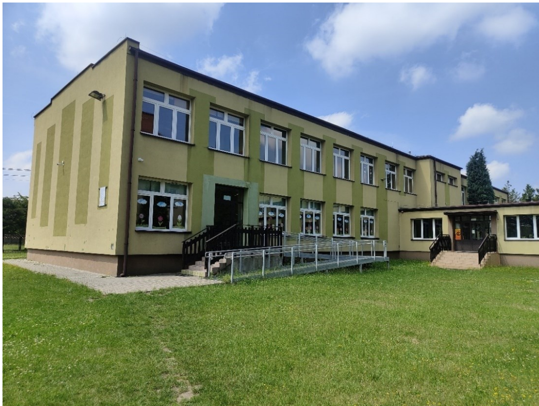
Fotografia 2. Widok szkoły od strony elewacji północnej
