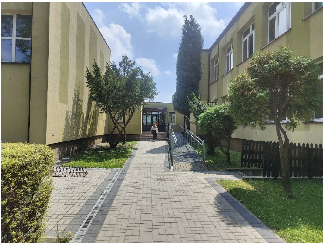
Fotografia 4. Widok szkoły od strony elewacji zachodniej - ujęcie 1
