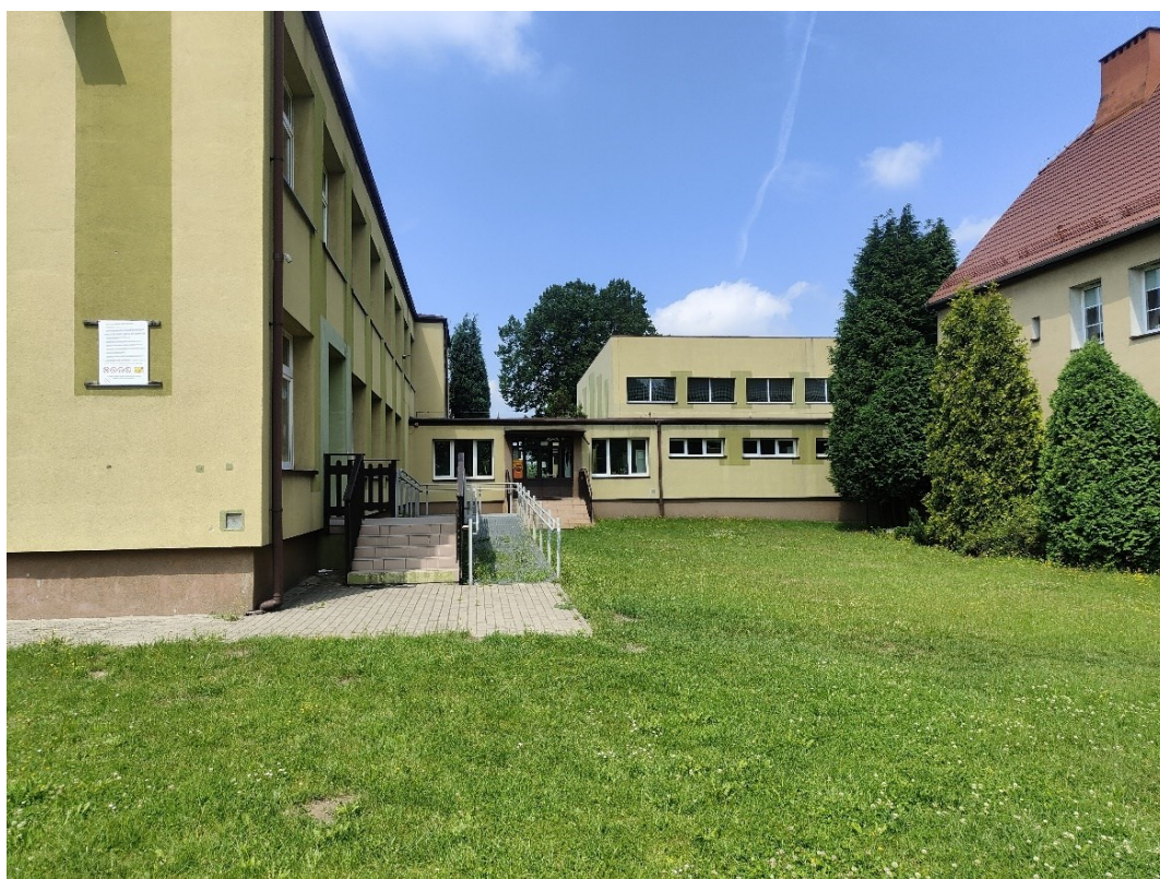
Fotografia 3. Widok szkoły od strony elewacji wschodniej
