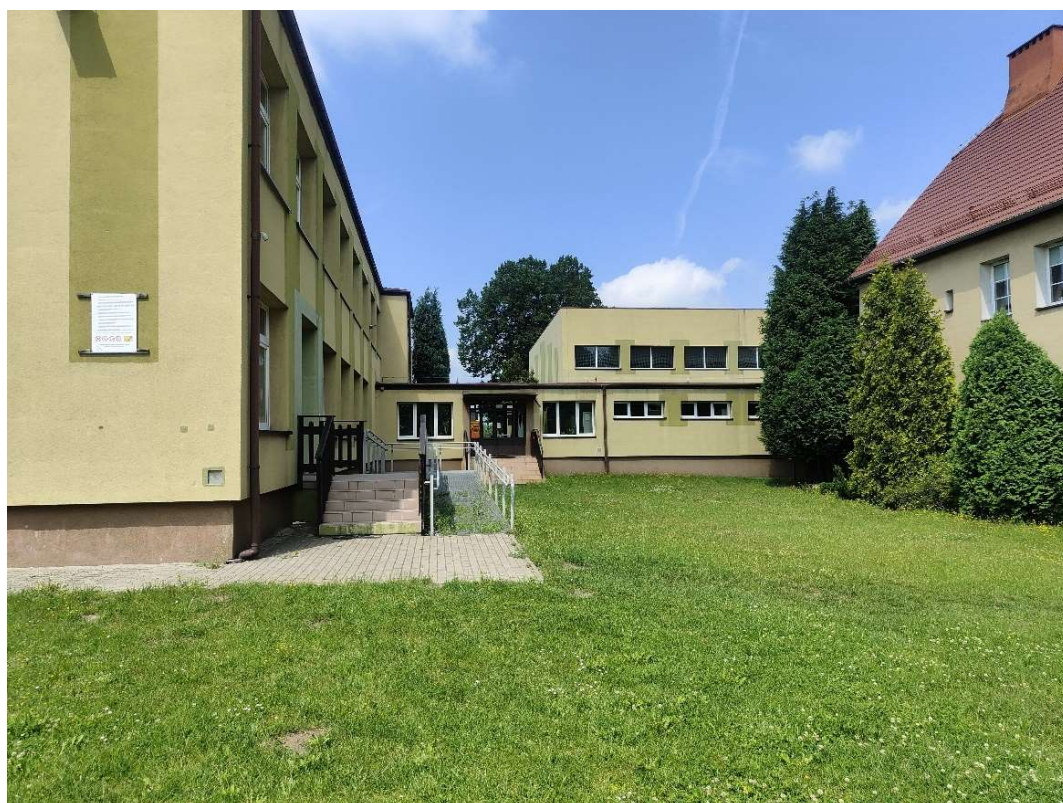
Fotografia 3. Widok szkoły od strony elewacji wschodniej
