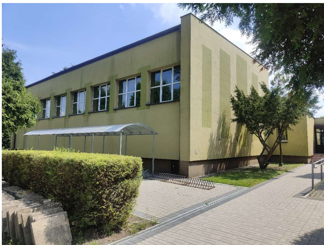
Fotografia 5. Widok szkoły od strony elewacji zachodniej – ujęcie 2
