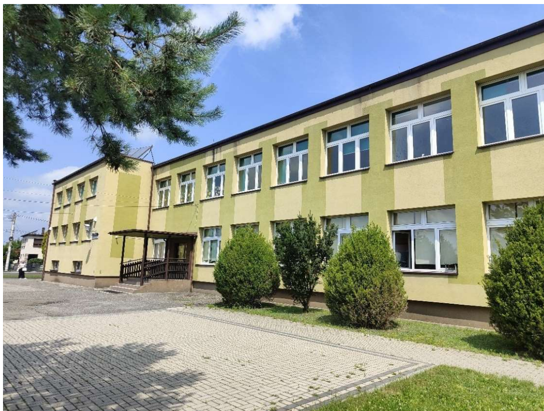
Fotografia 1. Widok szkoły od strony elewacji południowej
