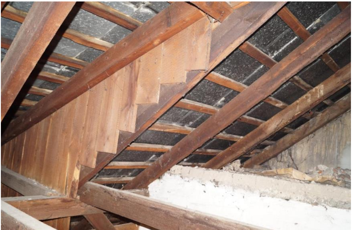
Poddasze budynku mieszkalnego
