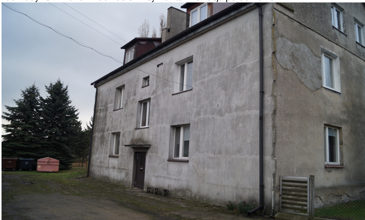
Fot. Elewacja północna budynku
