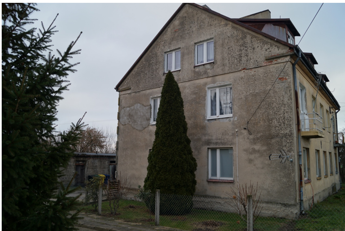
Fot. Elewacja zachodnia budynku.
