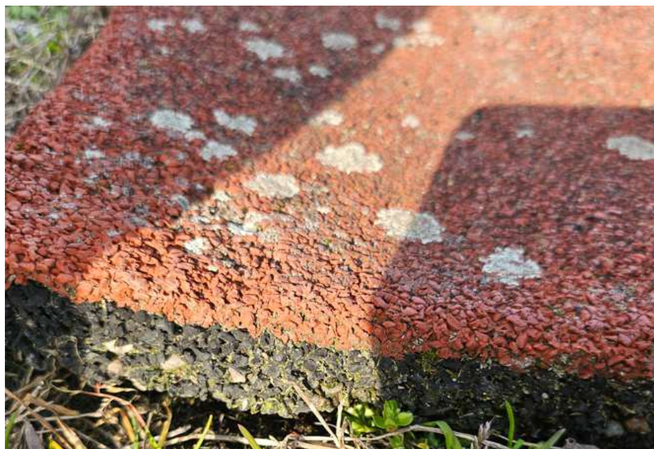
Fot. 3 Widok zanieczyszczeń biologicznych na istniejącej nawierzchni boiska wielofunkcyjnego oraz odspojenia nawierzchni od podłoża
