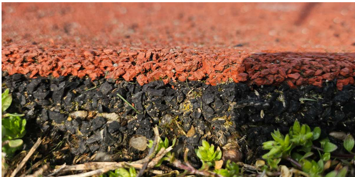
Fot. 2 Widok w przekroju istniejącej nawierzchni boiska wielofunkcyjnego
