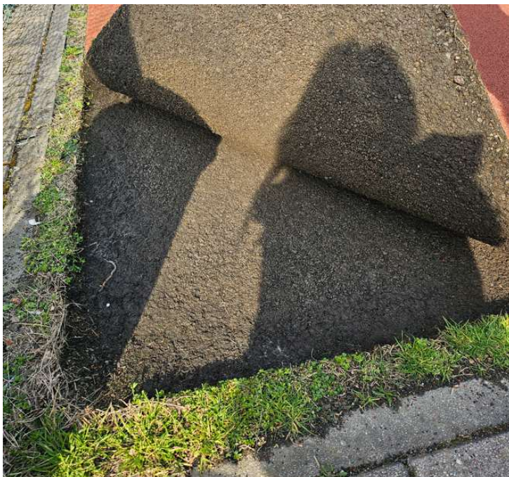
Fot. 4 Widok podbudowy pod istniejącą nawierzchnią syntetyczną boiska oraz skurczenia nawierzchni
