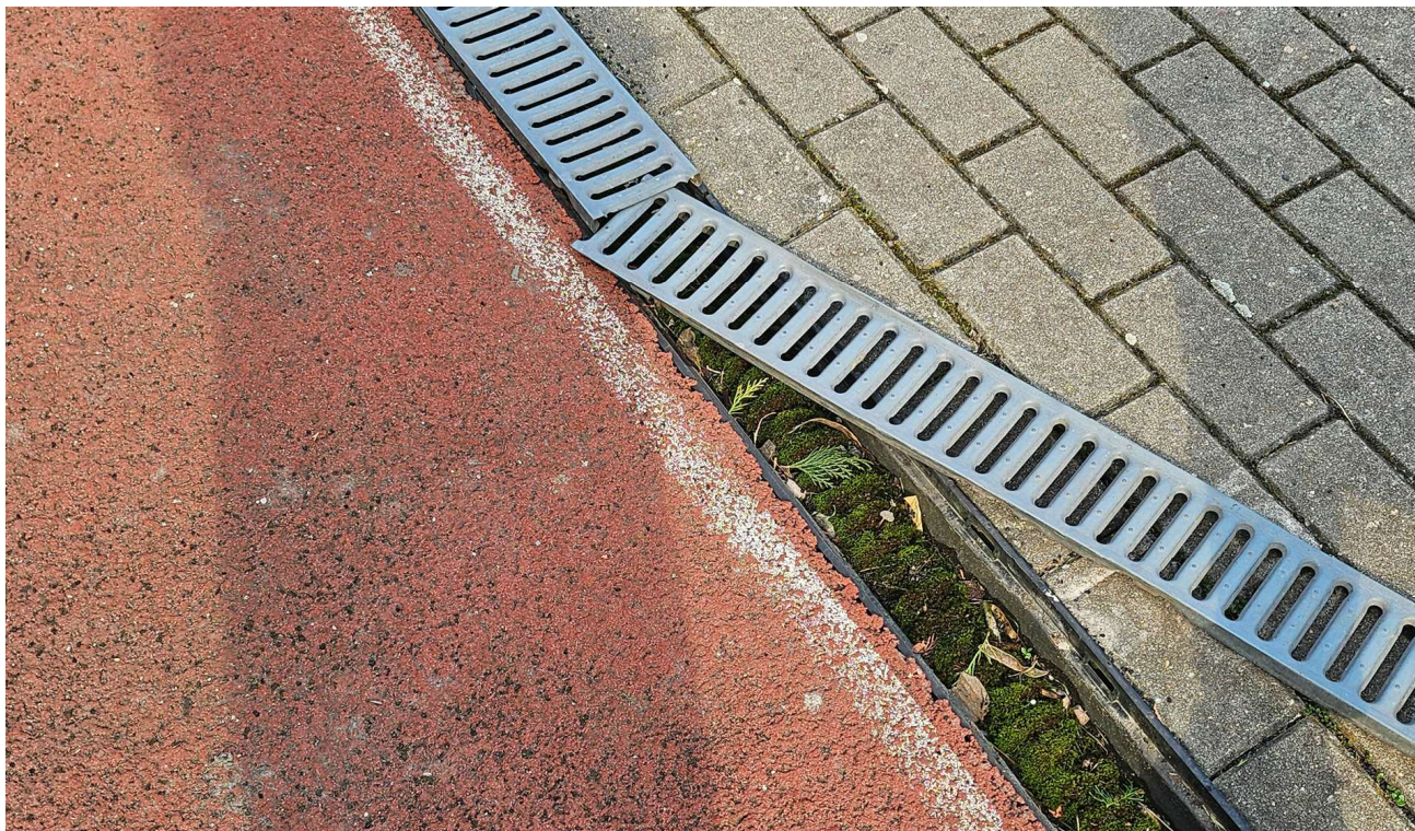
Fot. 9 Widok fragmentu koryt liniowych przy bieżni
