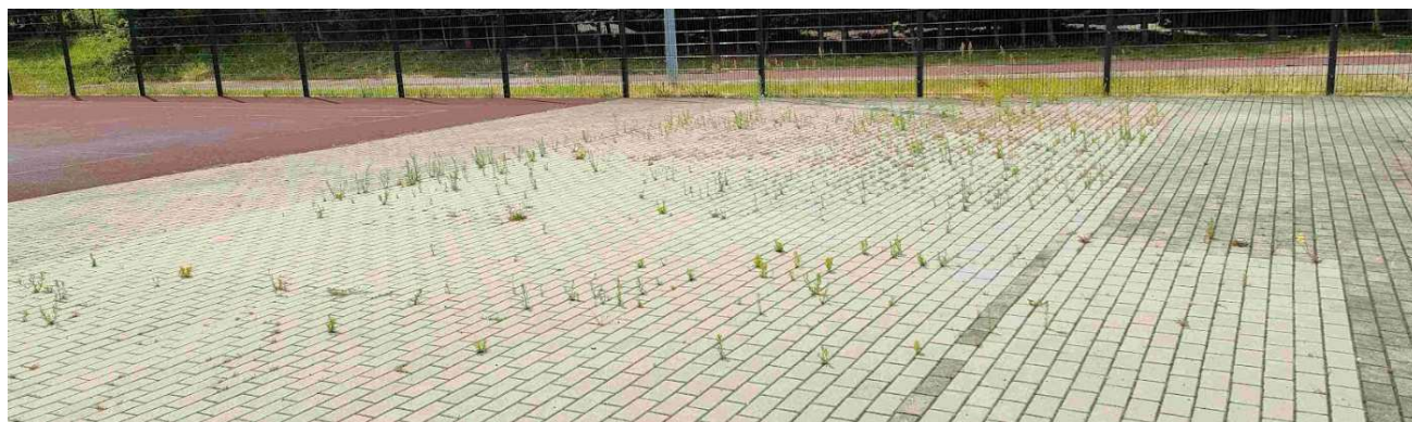
Fot. 11 Widok zanieczyszczonej biologicznie nawierzchni z kostki betonowej
