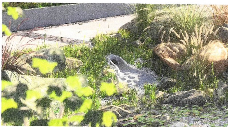
Insp. 4. Przykładowe rozwiązanie „rzygacza” podłączonego do odwodnienia liniowego, które odprowadza wodę do ogrodu deszczowego https://www.aco.pl/
