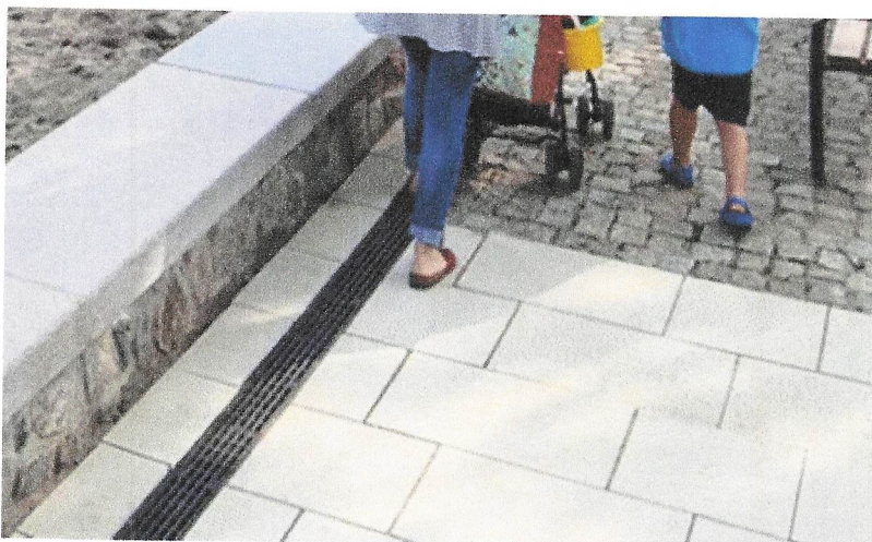
Insp. 2. Przykładowe estetycznie wykonane odwodnienie liniowe terenów utwardzonych w miastach https://www.aco.pl/
