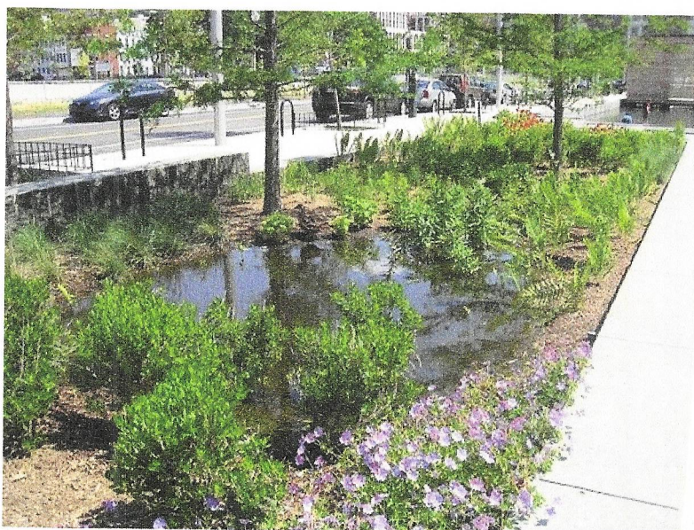
Insp. 10. Przykładowy ogród deszczowy w podłożu przepuszczalnym https://pl.pinterest.com/
