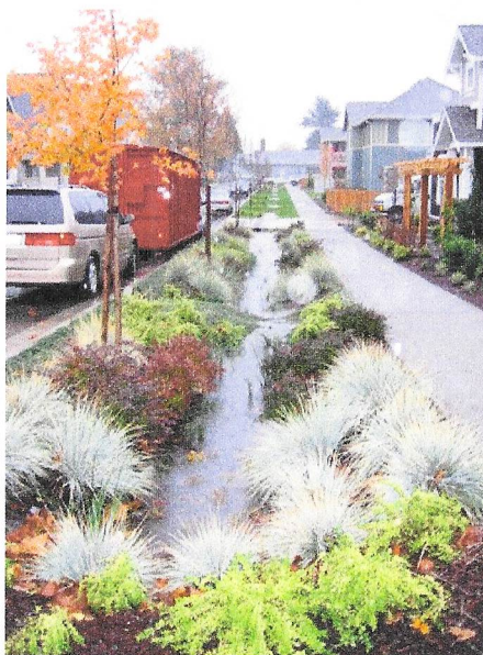
Insp. 15 i 16. Przykładowy ogród deszczowy na cieku wodnym https://pl.pinterest.com/
