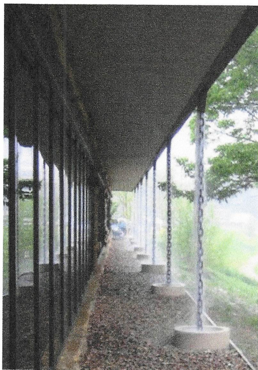
Insp. 14. Przykładowe rozwiązanie odprowadzenia wody z dachu za pomocą łańcuchów stalowych https://pl.pinterest.com/
