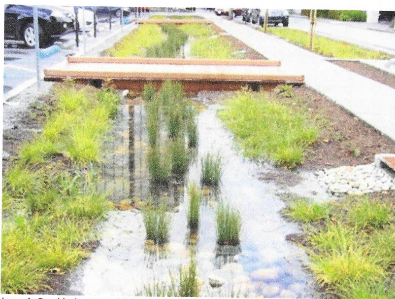
Insp. 1. Przykładowy ogród deszczowy magazynujący wodę https://pl.pinterest.com/
