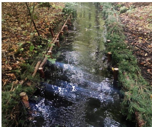
Umocnienia rowu kiszką faszynową
