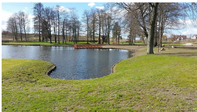
Widok na staw - umocnienia skarpy kiszka faszynową.
