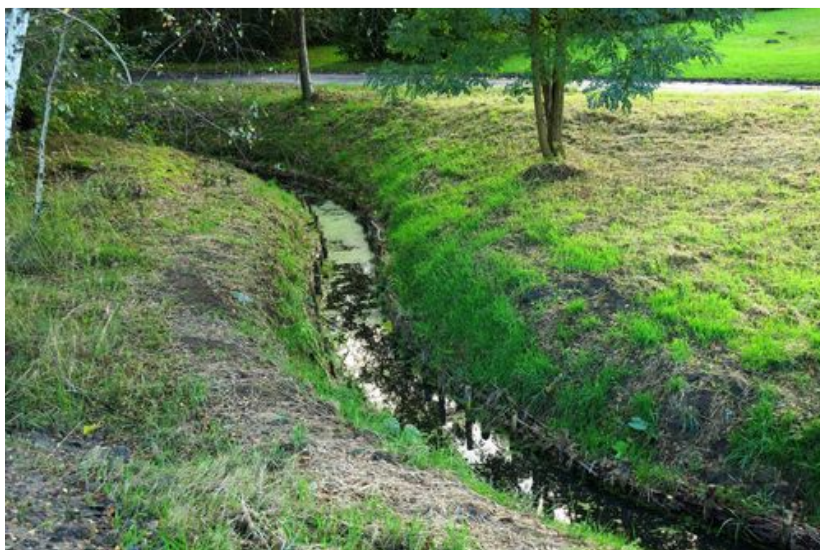
Rów po przeprowadzonych robotach utrzymaniowych
