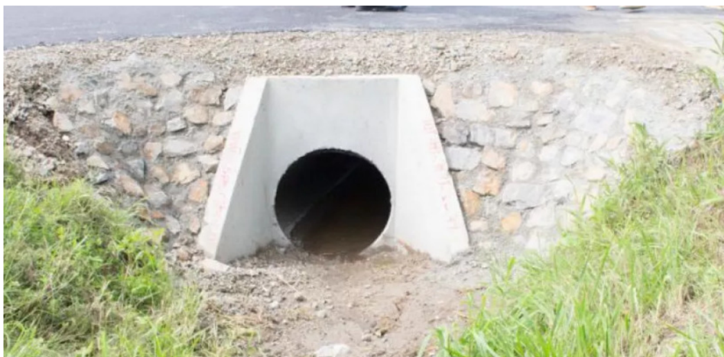
Przyczółki przepustu z kamienia
