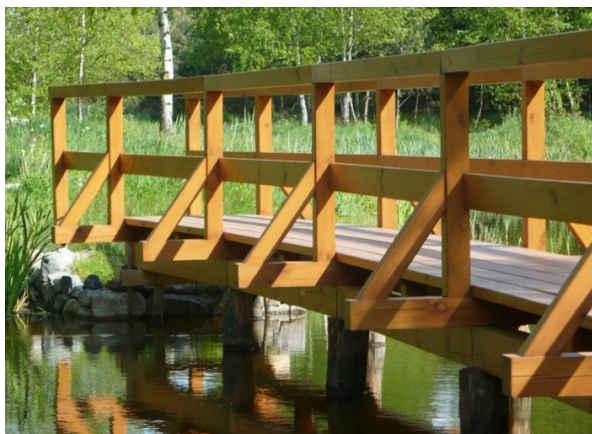
Rozwiązanie konstrukcyjne poręczy pomostów.
