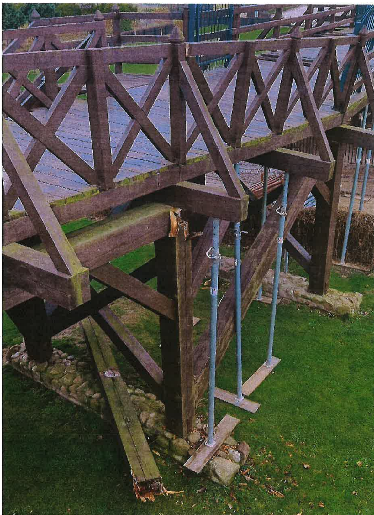
Fot. nr 4. Uszkodzenia słupa pod kładką od strony północno-wschodniej.
