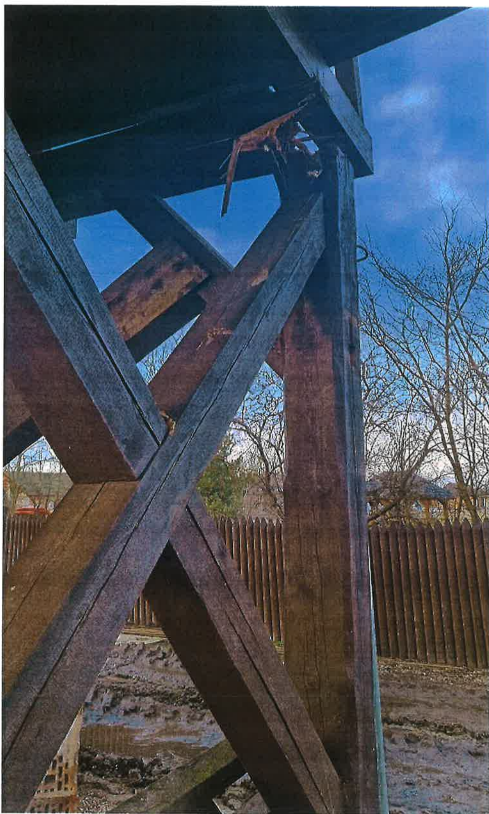
Fot. nr 12. Stężenia słupów pomostu.
