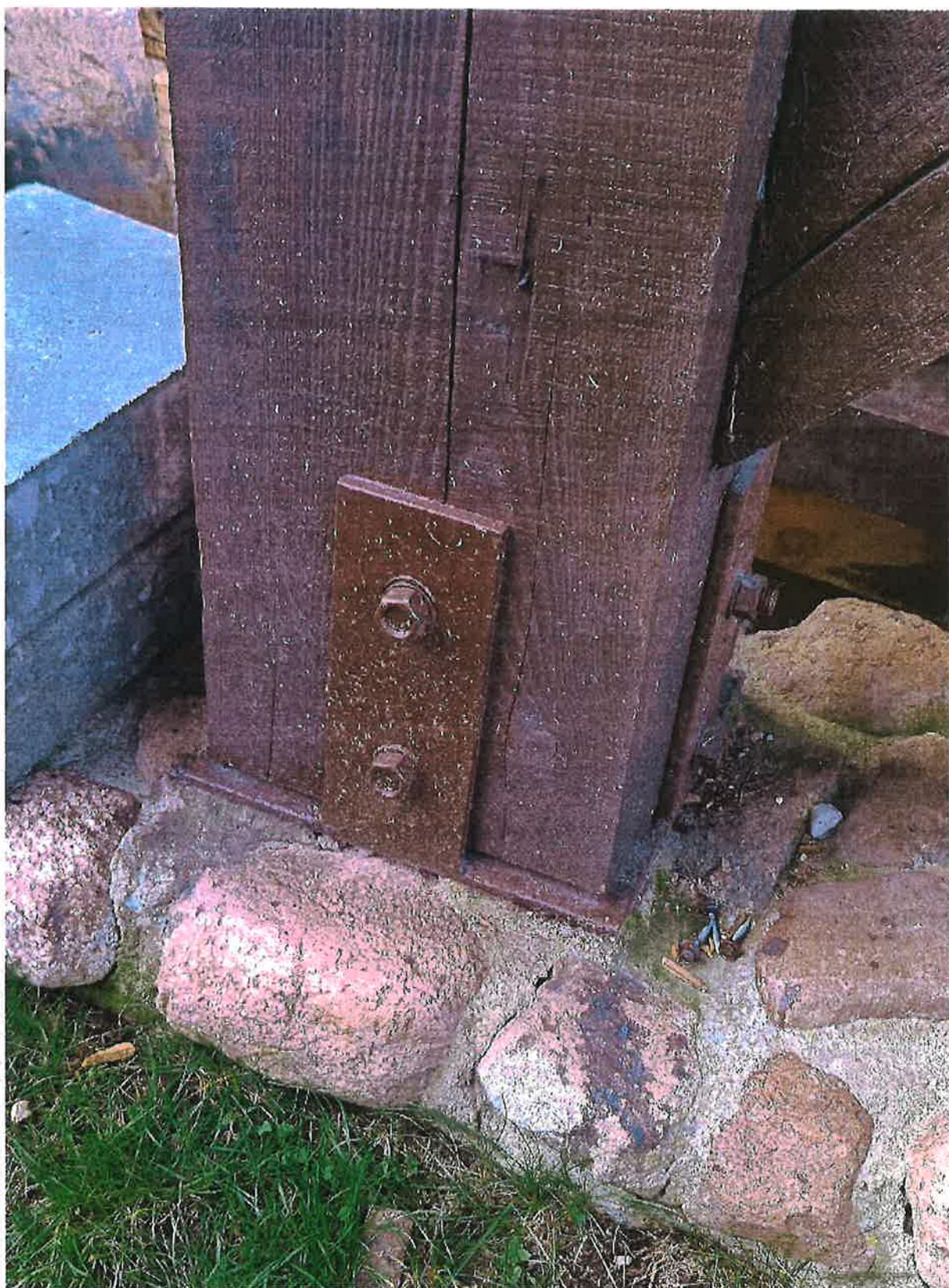
Fot. nr 2. Stopa fundamentowa po awarii.
