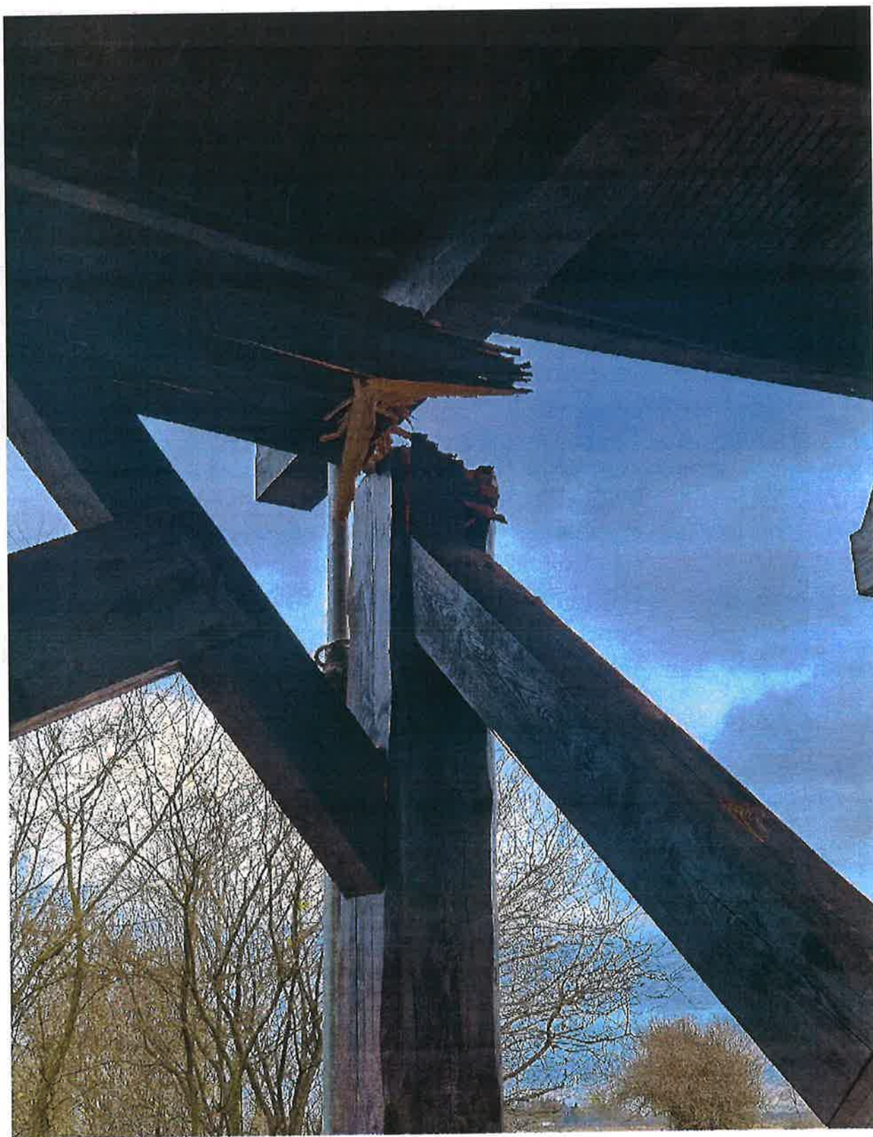
Fot. nr 3. Uszkodzenia słupa pod pomostem od strony północno-zachodniej.
