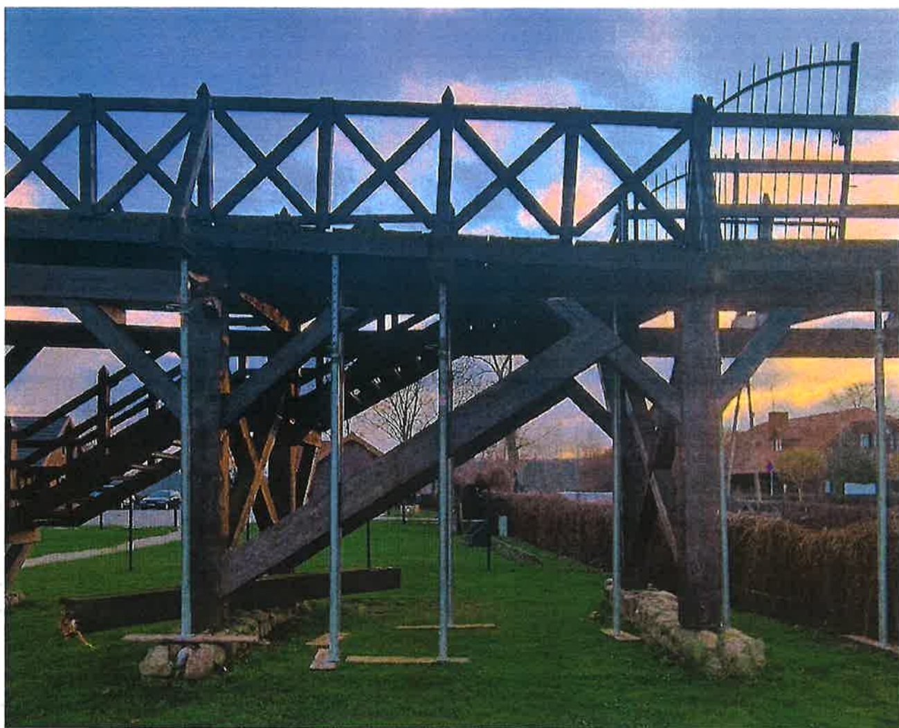
Fot. nr 8. Część pomostu z wyrwanymi belkami głównymi.
