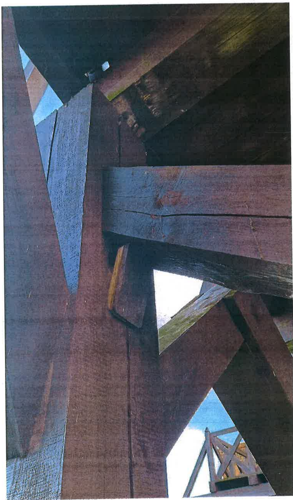
Fot. nr 13. Uszkodzenie połączenia słupa ze stężeniem.
