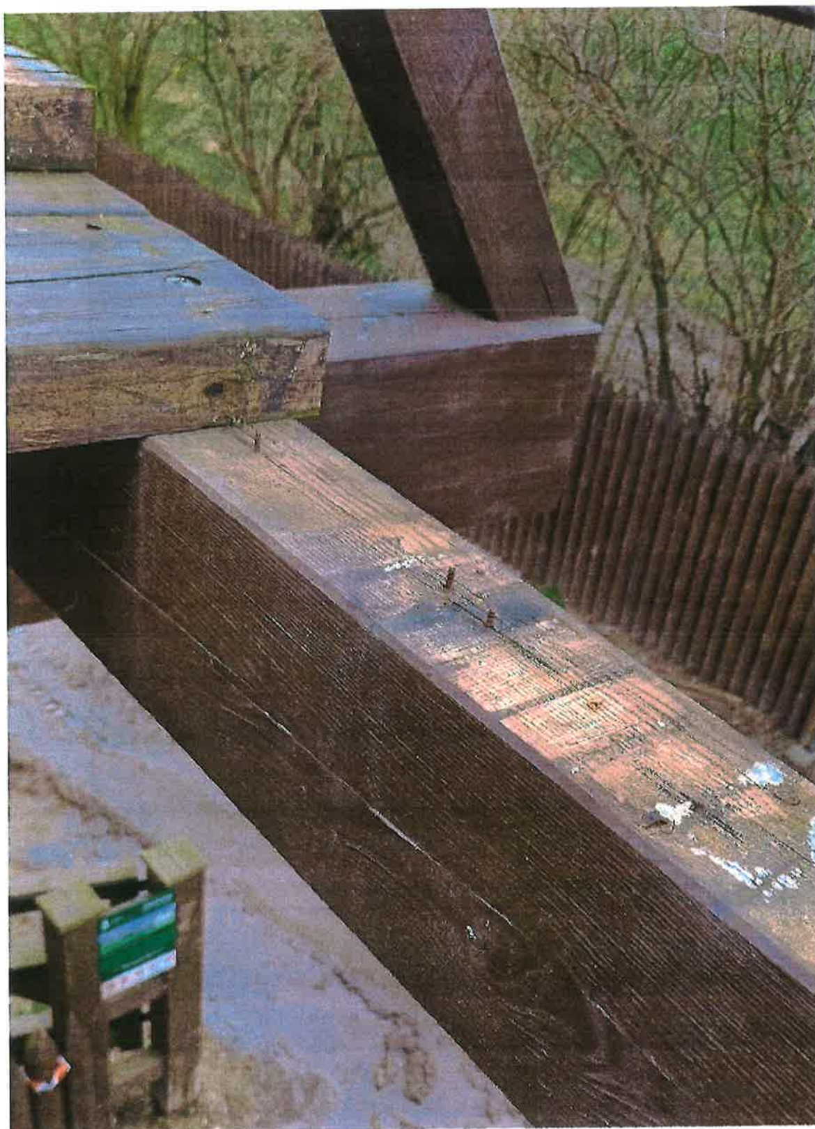
Fot. nr 11. Ścięte wkręty mocujące deski podłogowe z legarami.
