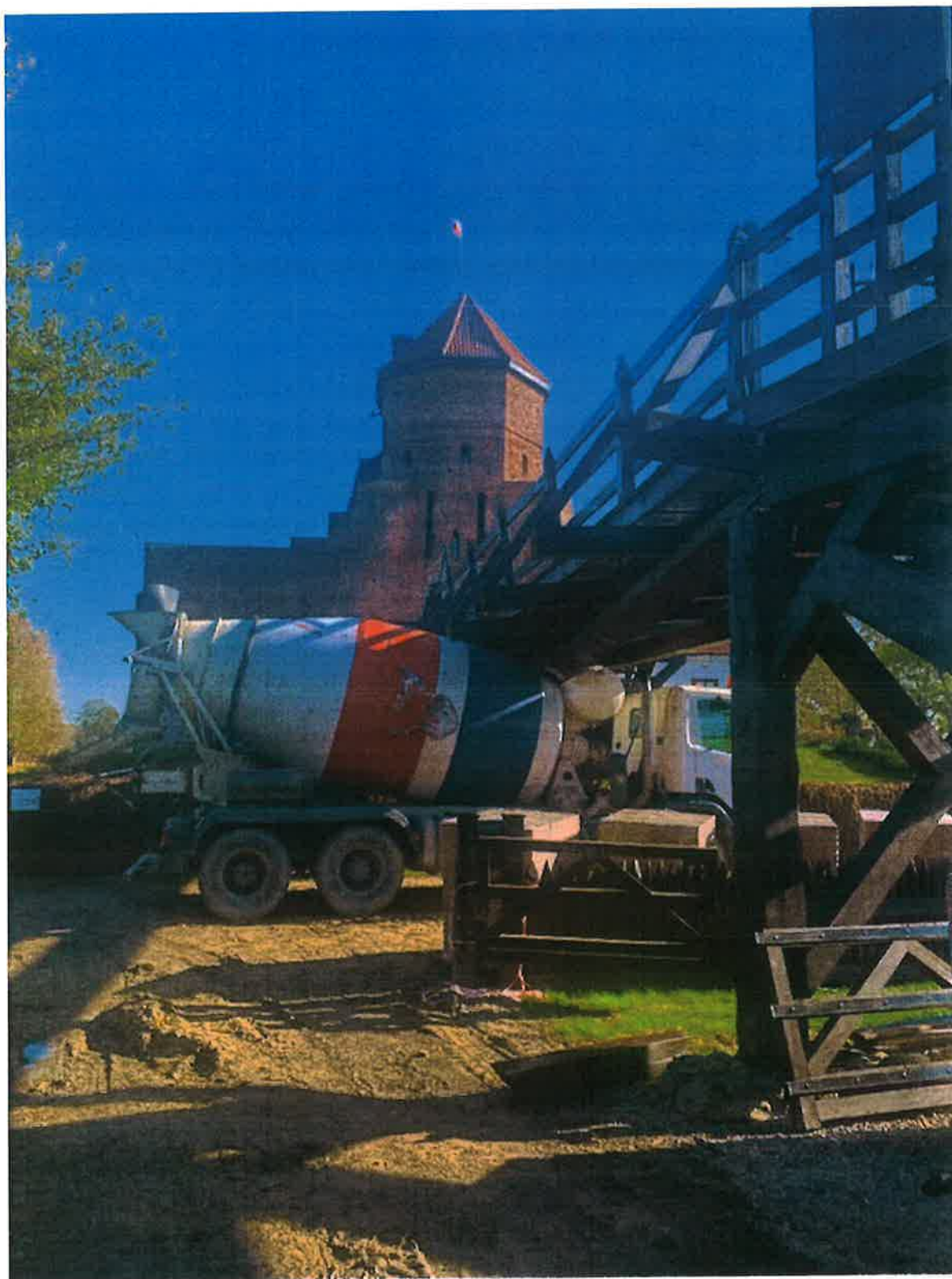
Fot. nr 1. Uderzenie samochodu ciężarowego w kładkę dla pieszych.
