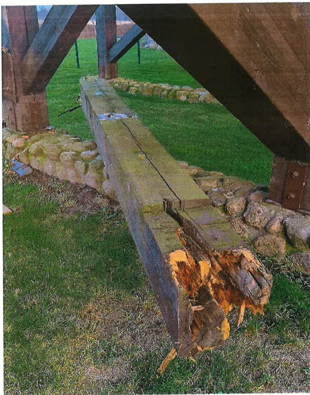
Fot. nr 7. Uszkodzona belka główna drewniana.
