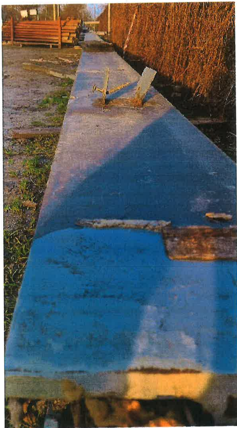
Fot. nr 5. Stalowa belka główna kładki.
