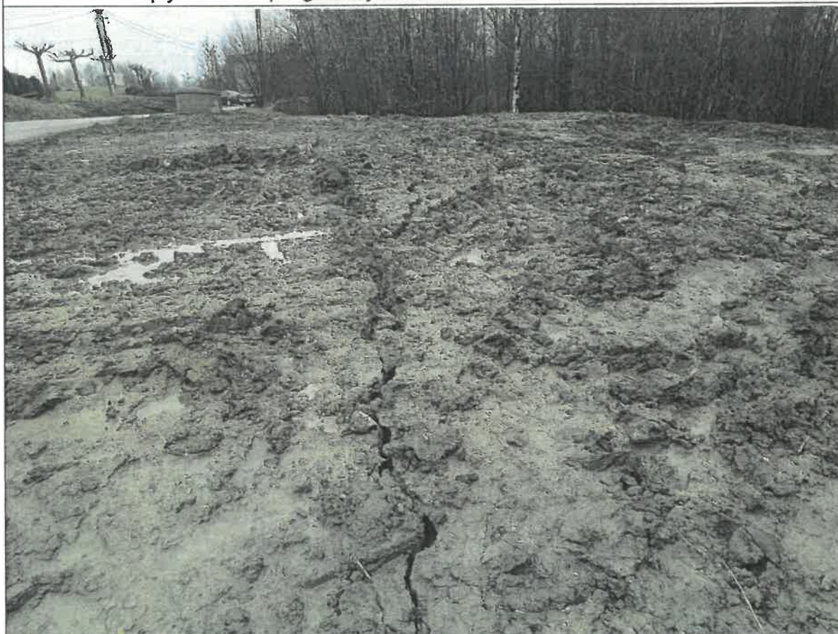
Szczeliny osuwiskowe w nasypie w północnej części skarpy głównej
