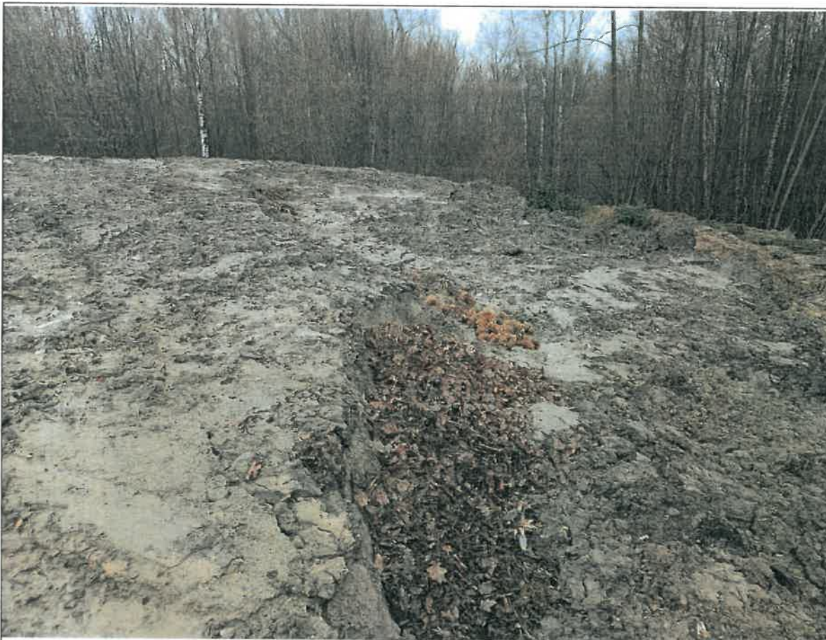
Skarpa główna osuwiska w północnej części (nasyp)
