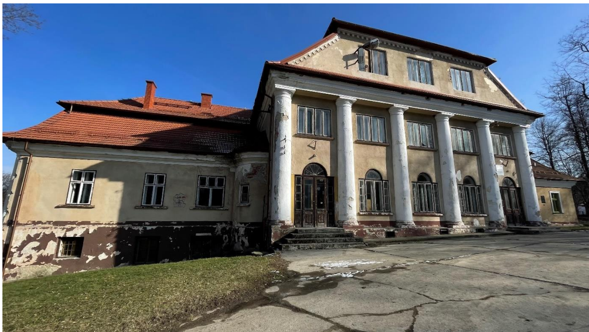
Elewacja frontowa od strony północno-zachodniej
