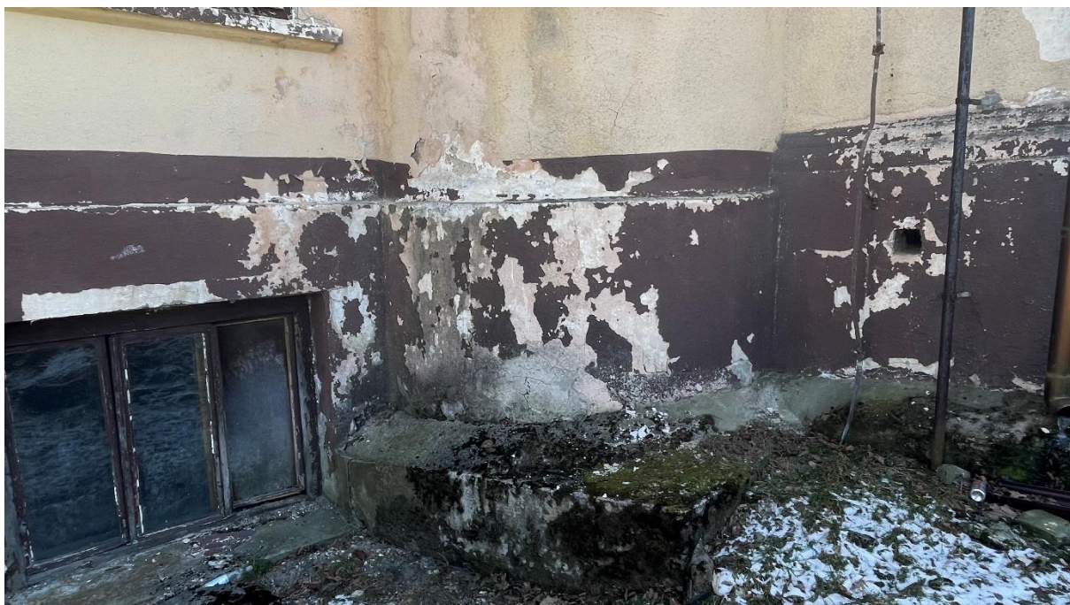
Fragment cokołu od strony północno-zachodniej (klatka schodowa do piwnicy)
