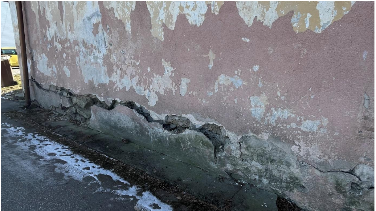
Fragment przyziemia elewacji północnej
