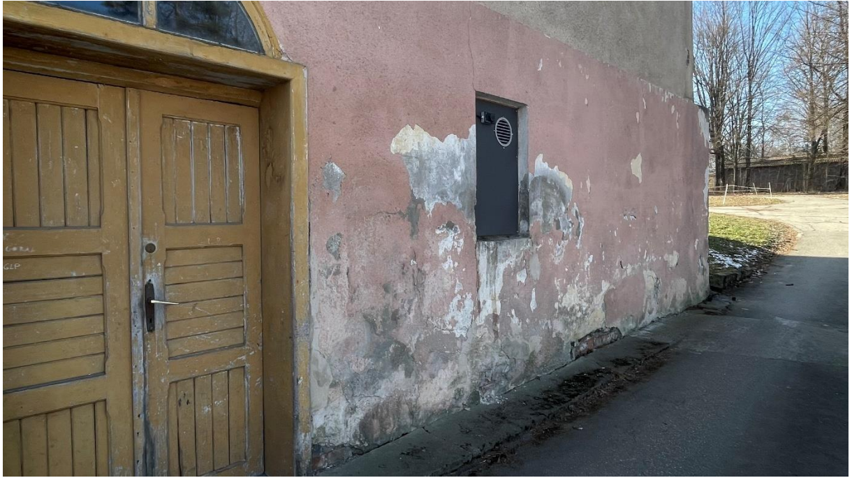
Fragment przyziemia elewacji północnej
