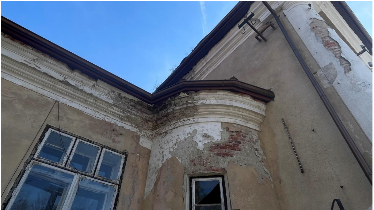
Fragment elewacji od strony północno-zachodniej (klatka schodowa do piwnicy)
