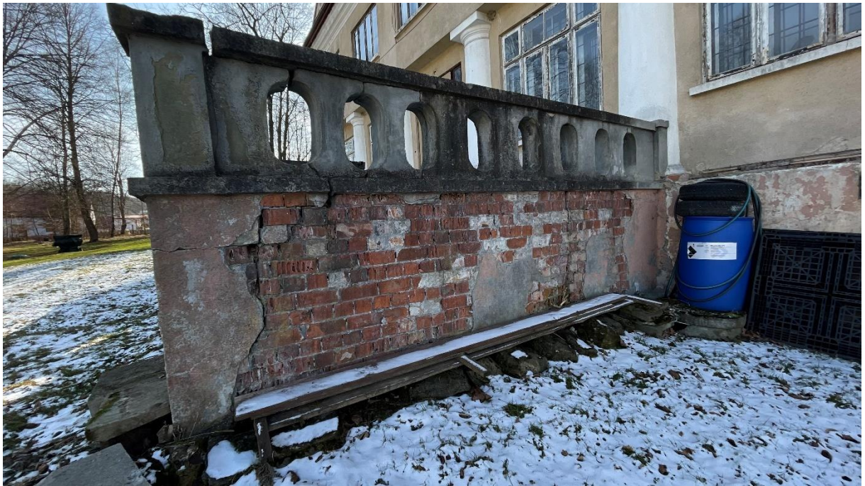
Taras przy ryzalicie w elewacji wschodniej
