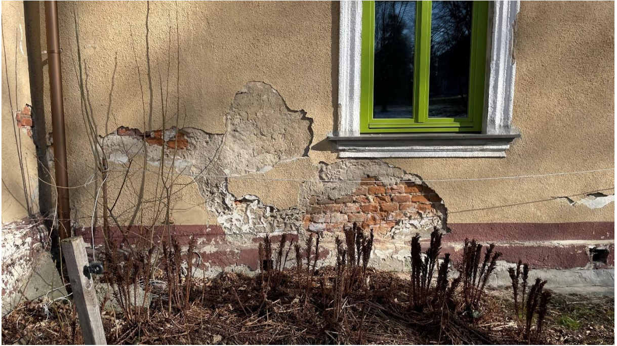
Fragment przyziemia elewacji zachodniej
