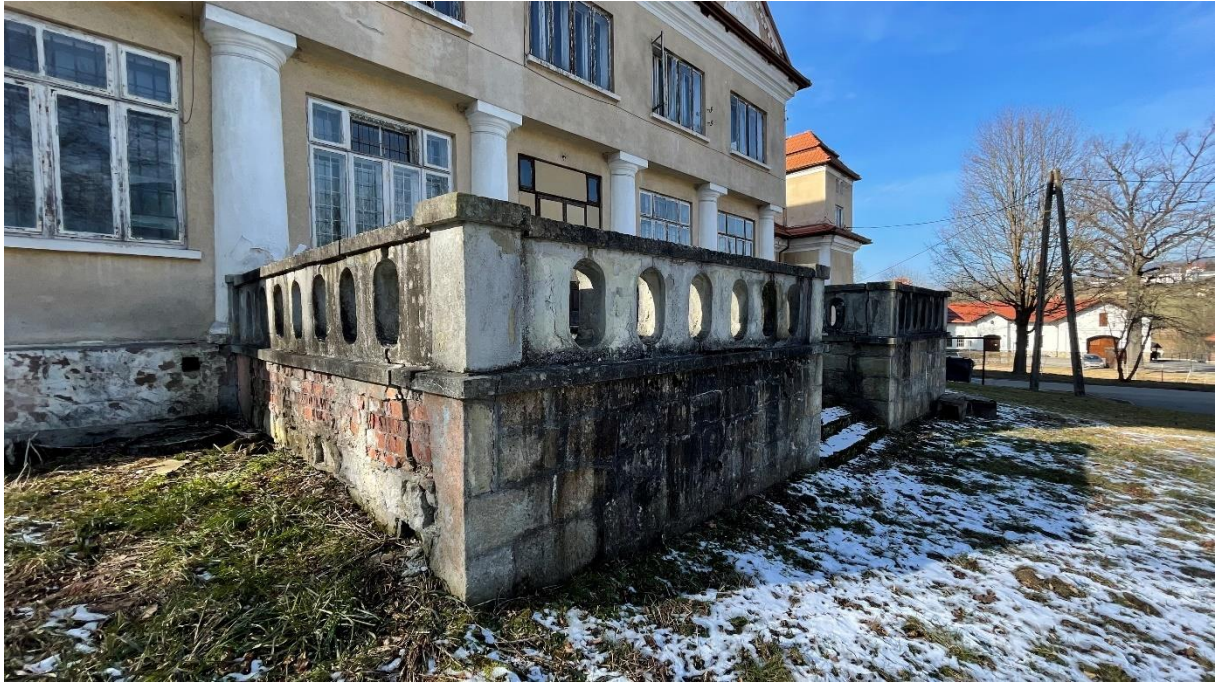
Taras przy ryzalicie w elewacji wschodniej
