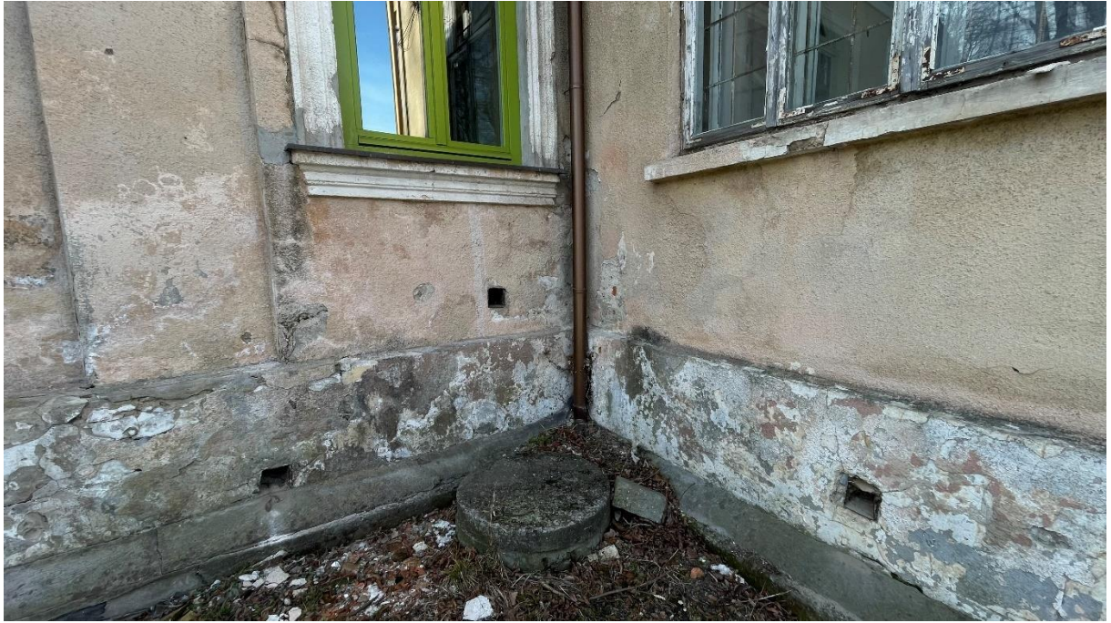
Fragment przyziemia elewacji wschodniej skrzydła południowego z fragmentem ryzalitu
