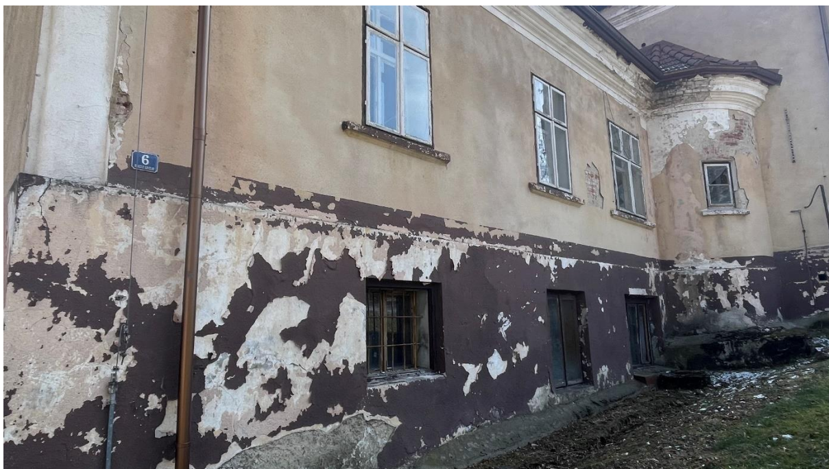
Fragment elewacji od strony północno-zachodniej (klatka schodowa do piwnicy)
