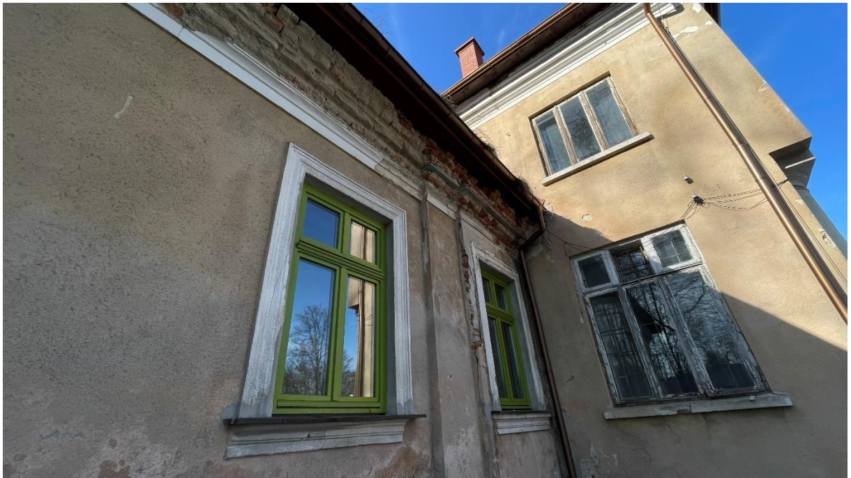
Fragment elewacji wschodniej skrzydła południowego z fragmentem ryzalitu
