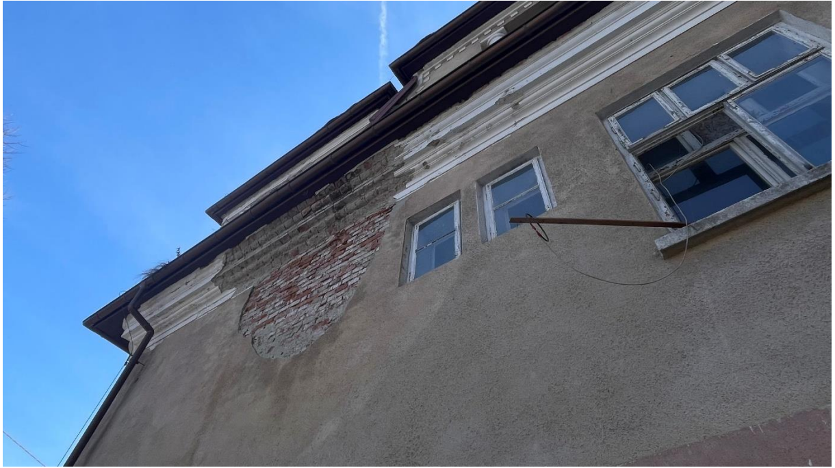
Fragment elewacji północnej
