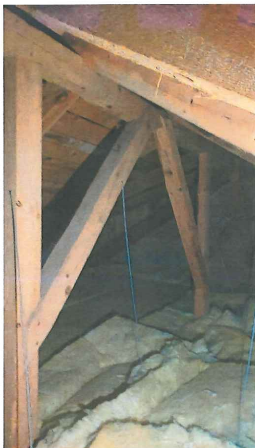
Rys. 4.8 Widok więźby dachowej w części południowej obiektu.
