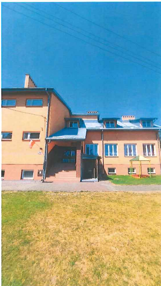
Rys. 3.4 Widok elewacji wschodniej (frontowej).
