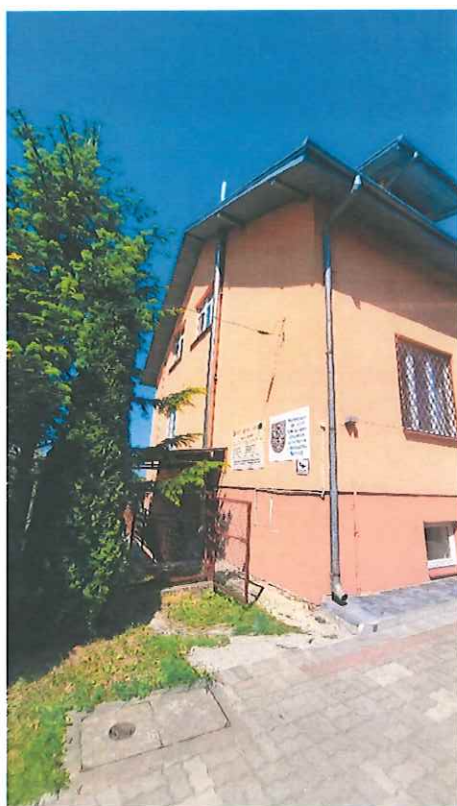
Rys. 3.2 Widok elewacji południowej.
