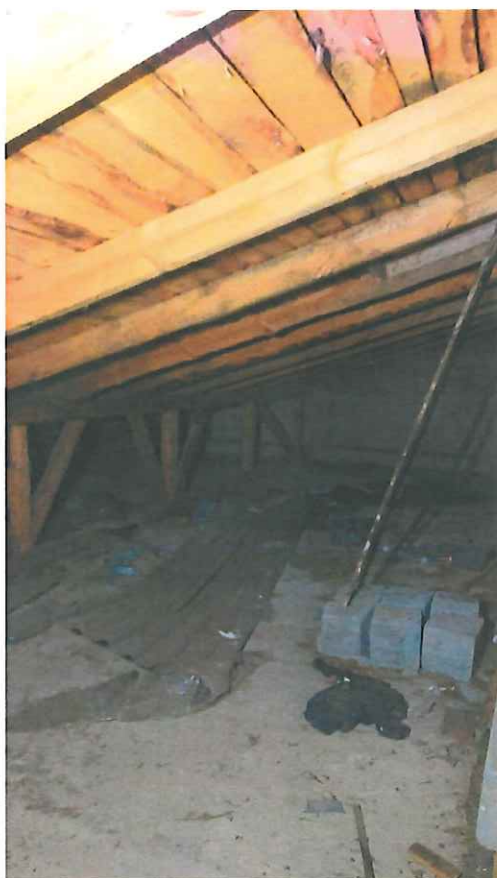
Rys. 4.6 Widok więźby dachowej opartej na żelbetowym i stalowo-murowanym stropie w części północnej obiektu.
