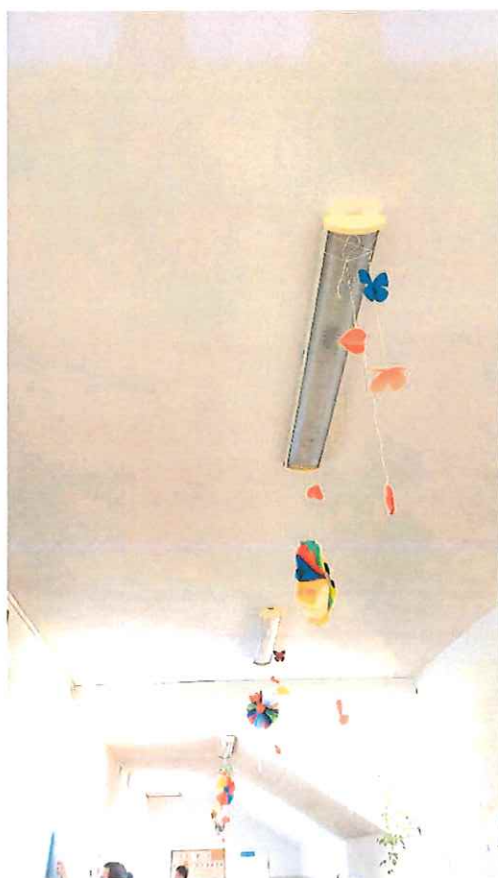
Rys. 4.2 Widok stropu na belkach stalowych nad korytarzem – strop nad I-szym piętrzem.
