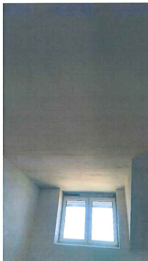
Rys. 4.3 Widok stropu na belkach stalowych nad klatką schodową – strop nad I-szym piętrzem.
