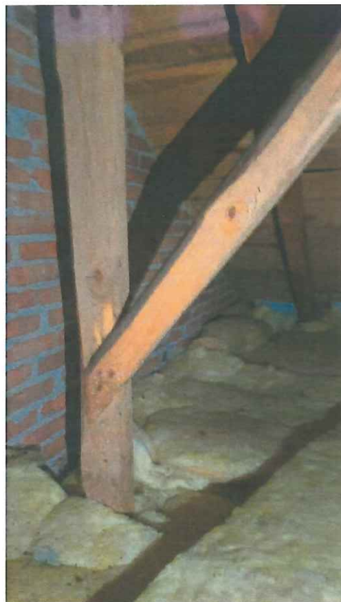
Rys. 4.9 Widok więźby dachowej w części południowej obiektu.
