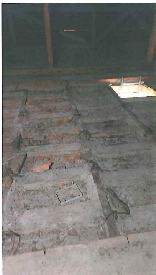
Rys. 4.4 Widok stropu na belkach stalowych nad korytarzem – strop nad I-szym pięciem.
