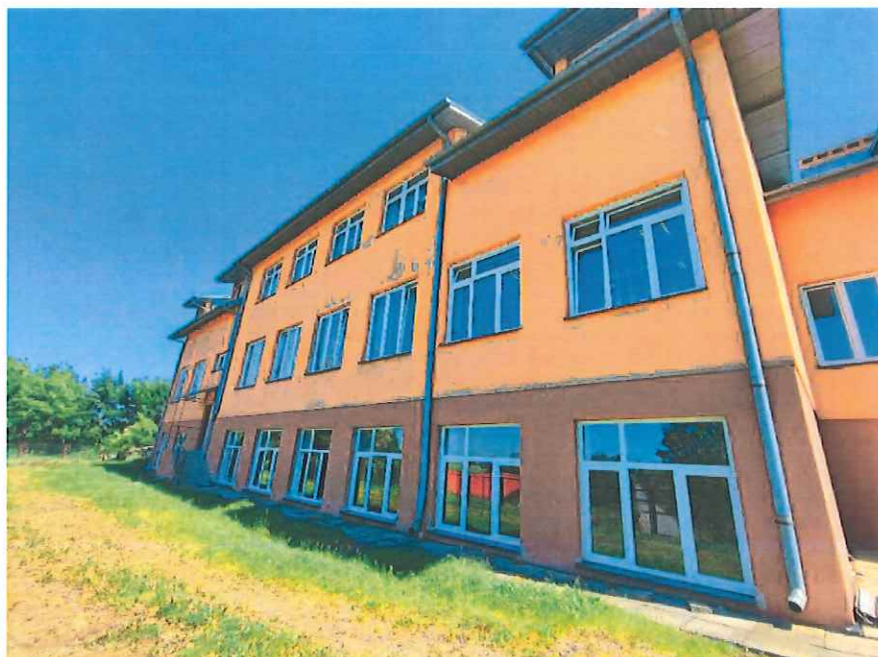
Rys. 3.6 Widok elewacji zachodniej.
