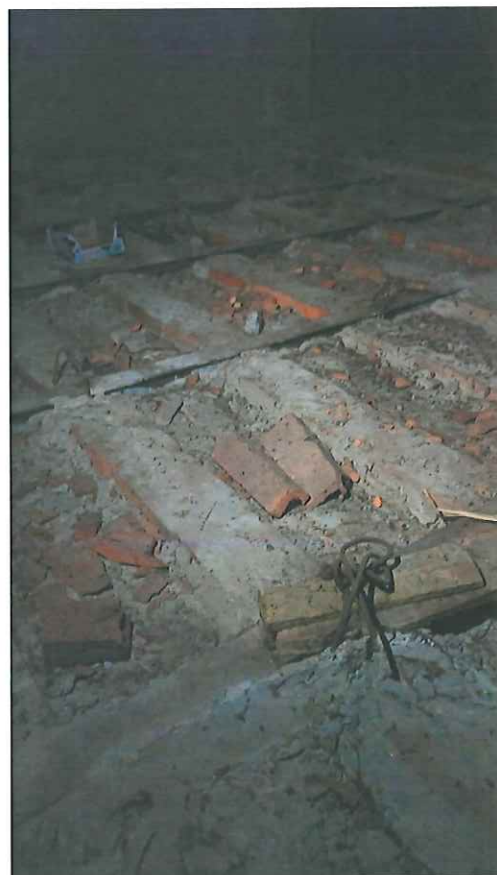
Rys. 4.5 Widok stropu na belkach stalowych nad korytarzem – strop nad I-szym pięciem.
