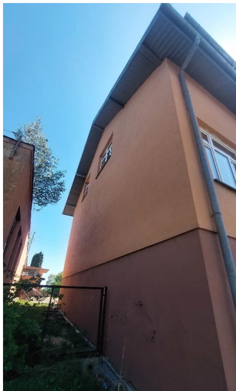
Widok elewacji szczytowej
