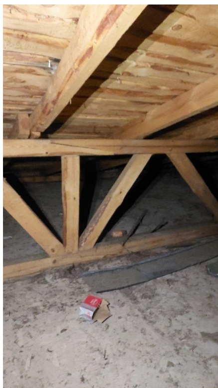
Widok więźby dachowej
