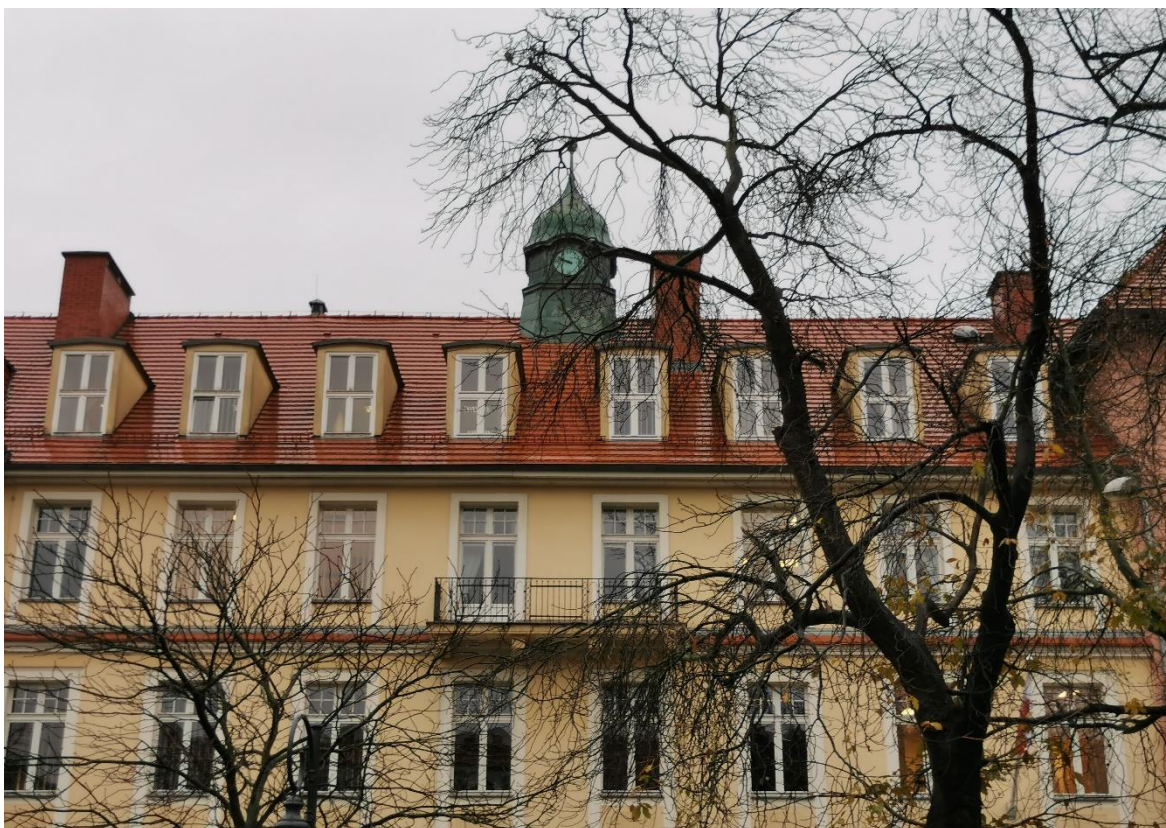
Il.9 Widok na fragment elewacji frontowej budynku Sądu Okręgowego w Opolu od strony pl. Daszyńskiego. Fot. S. Namyślak.
