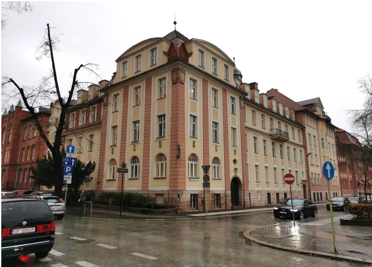
Il. 5 Widok na narożnik (ryzalit) elewacji frontowej budynku Sądu Okręgowego w Opolu. Fot. S. Namyślak.
