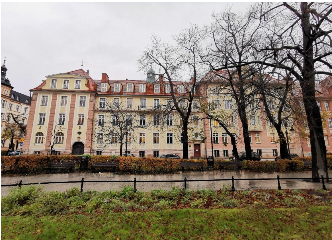
Il.8 Widok na elewację frontową budynku Sądu Okręgowego w Opolu od strony pl. Daszyńskiego. Fot. S. Namyślak.
