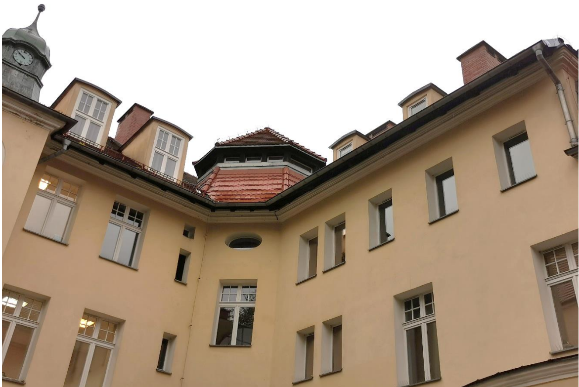
Il.19 Widok na fragment elewacji tylnej budynku Sądu Okręgowego w Opolu od strony pl. Daszyńskiego. Fot. S. Namyślak.
