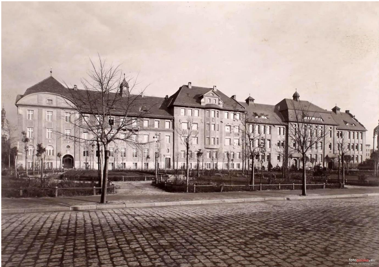
II.2 Zdjęcie archiwalne z roku ok. 1910. Widok na budynek obecnego Sądu Okręgowego w Opolu ( https://fotopolska.eu/519258,foto.html?o=b47218 ).
