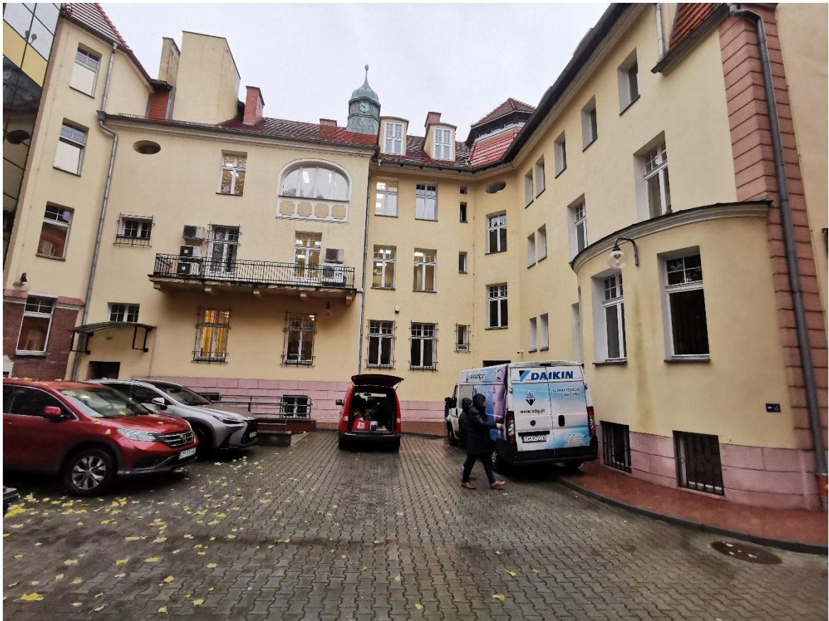
Il.18 Widok na elewację tylną budynku Sądu Okręgowego w Opolu od strony pl. Daszyńskiego. Fot. S. Namyślak.
