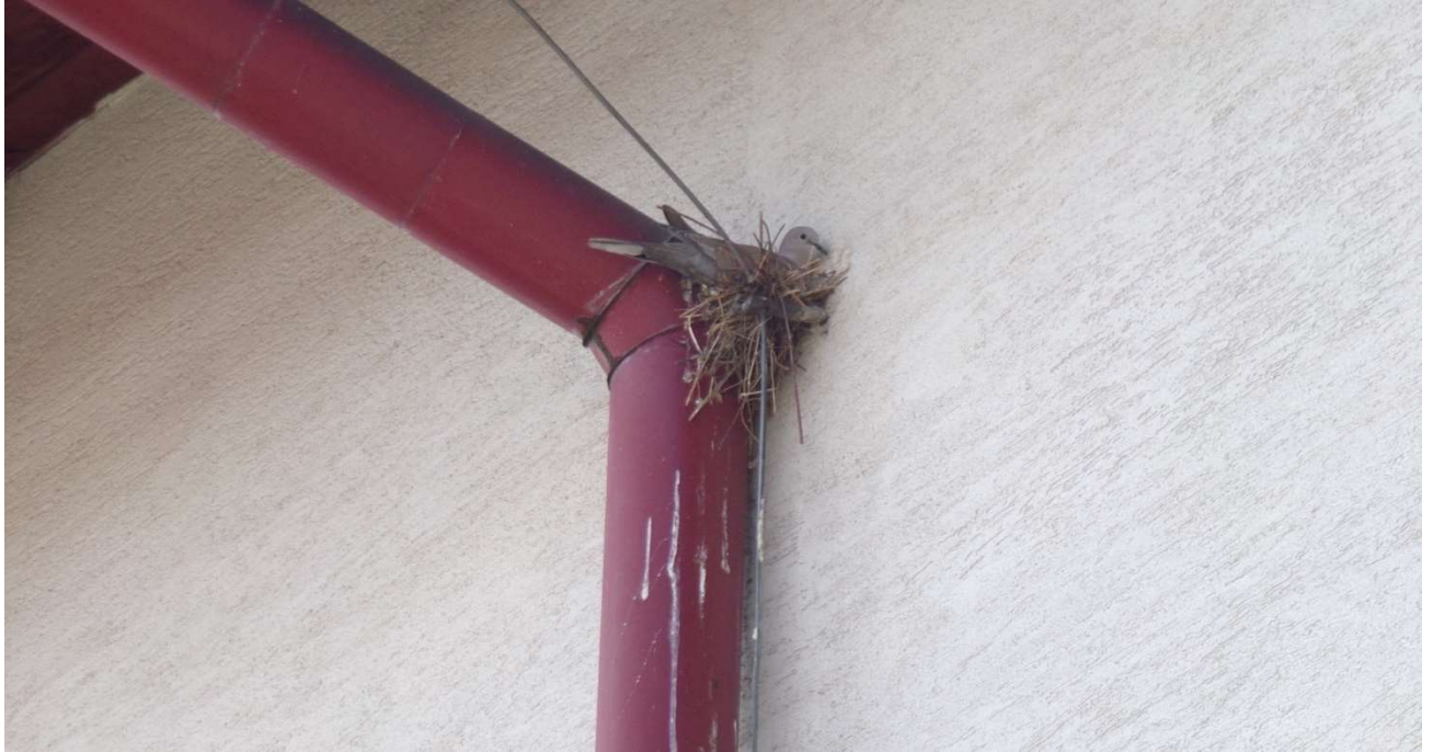
Grafika 10 Fot. elewacji 7 – zbliżenie na gniazdo synogarlicy (to samo co wyżej), 2 zdjęcia
