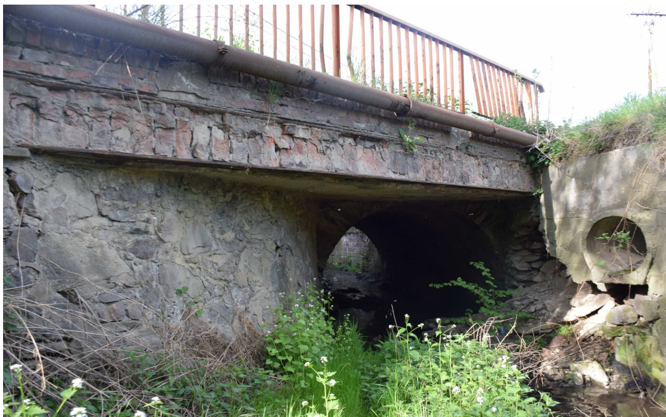
Widok ogólny obiektu mostowego
