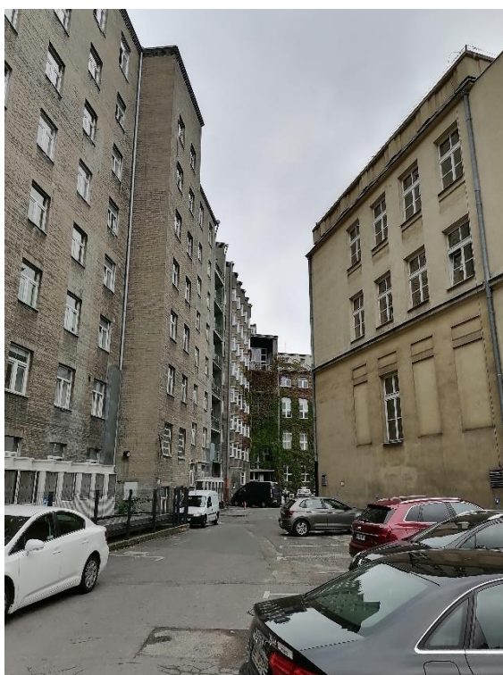
Widok styku z sąsiednim budynkiem użyteczności publicznej od strony południowej
