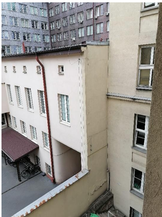
Widok styku z sąsiednim budynkiem użyteczności publicznej usytuowanym od strony wschodniej
