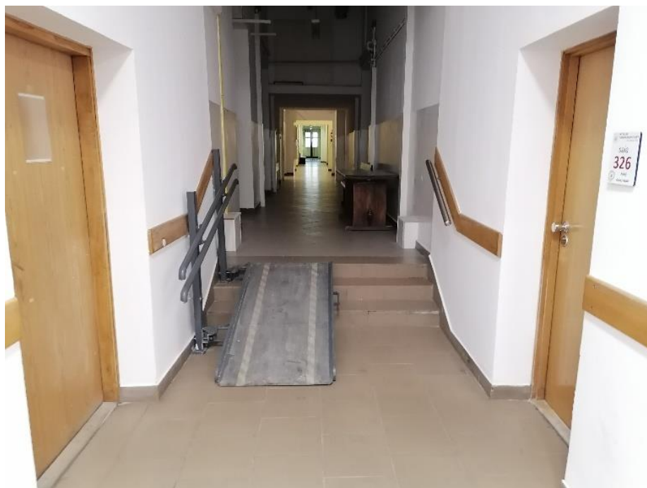
Widok schodów wewnętrznych SW9 od strony skrzydła zachodniego (pochylnia składana wykonana z materiałów niepalnych)
