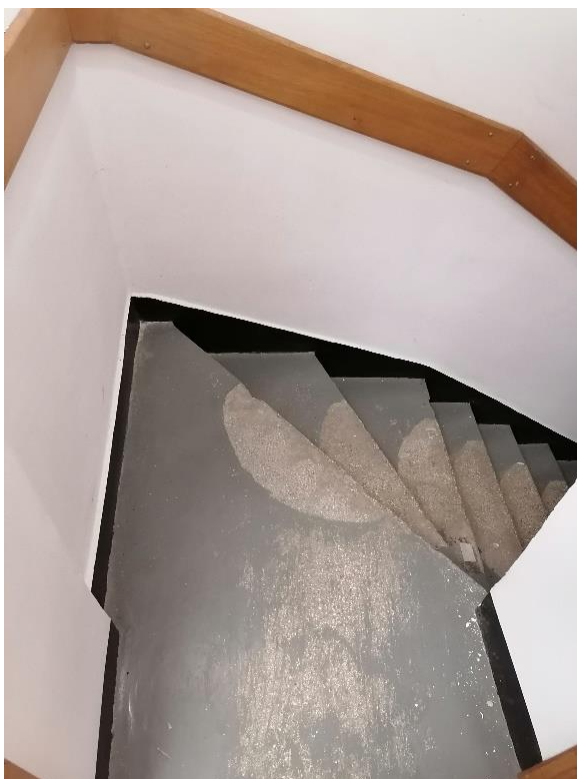
Widok stopni schodów zabiegowych prowadzących do kondygnacji podziemnej -1
