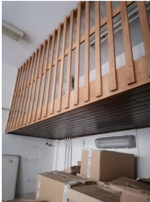
Widok drewnianej okładziny antresoli stanowiącej sufit
