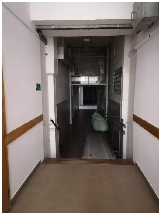
Widok schodów wewnętrznych SW7 od strony skrzydła zachodniego
