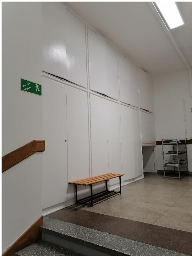
Widok szaf zlokalizowanych na korytarzach
