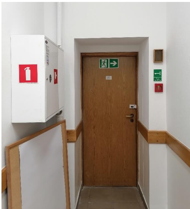
Widok przewężenie przed wejściem do klatki schodowej K2
