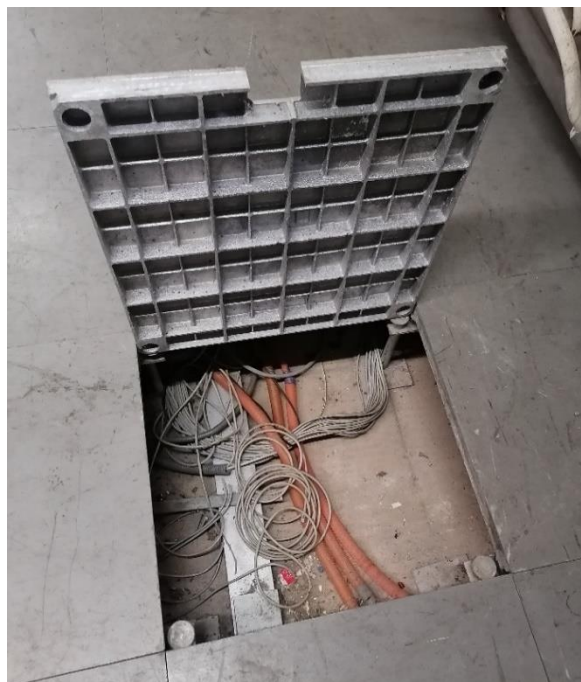
Widok podłogi podniesionej występującej w kondygnacji podziemnej -1.
