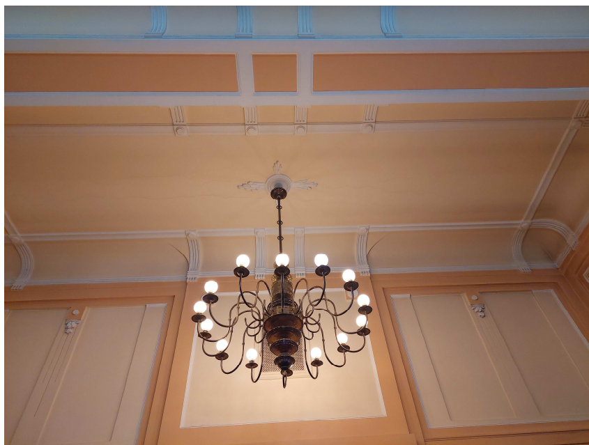
Zdjęcie nr 6 Widok przykładowego pomieszczenia
