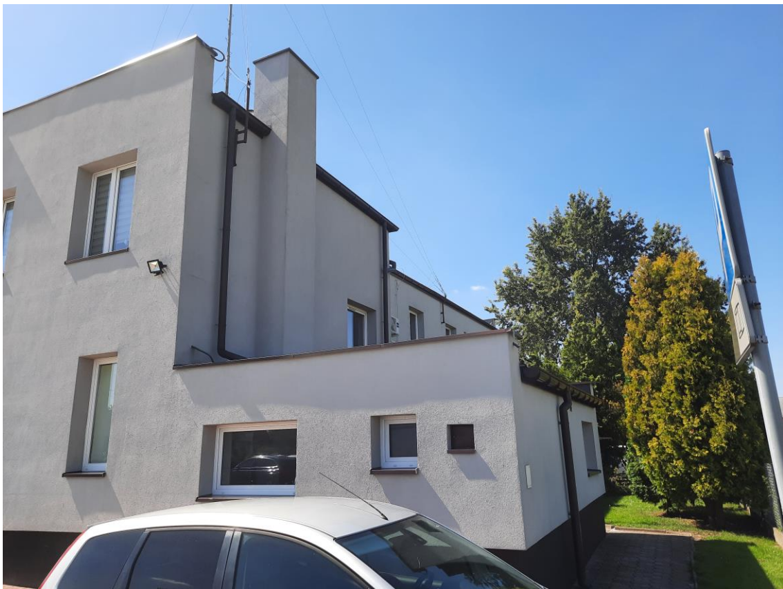
Zdjęcie 2. Elewacja północna
