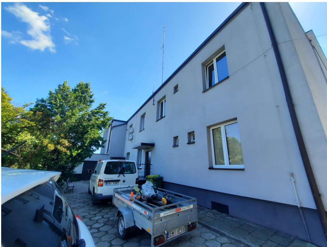
Zdjęcie 3. Elewacja północna
