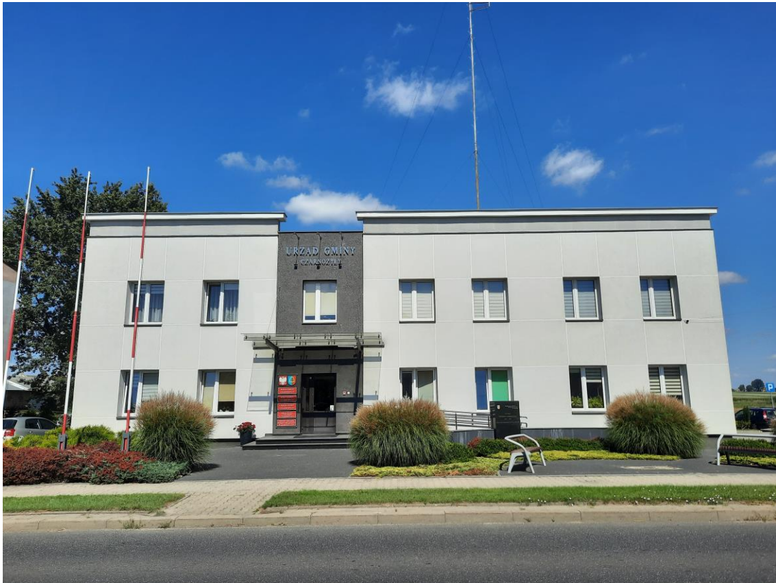
Zdjęcie 5. Elewacja południowa
