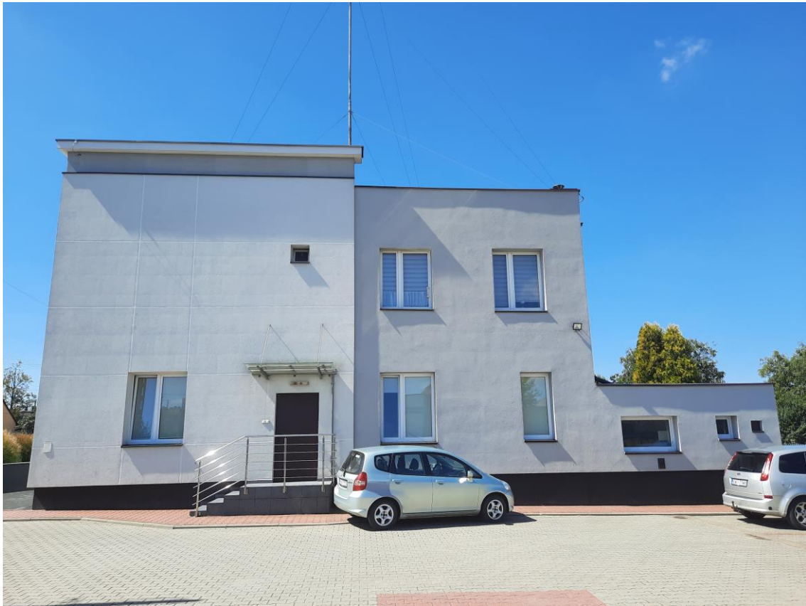
Zdjęcie 1. Elewacja wschodnia
