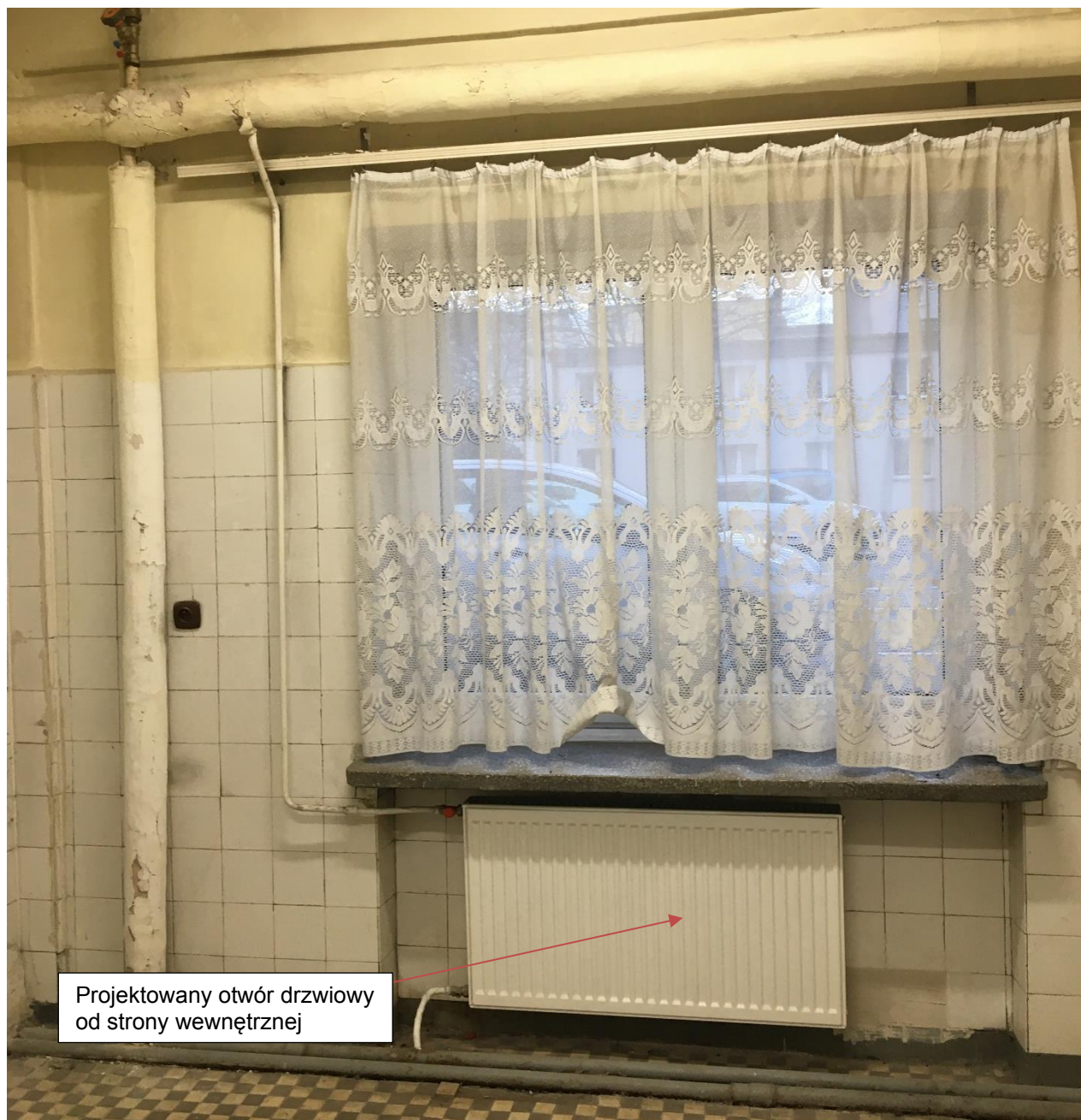
Rys. 2. Widok otworu okiennego, który zostanie otworem drzwiowym
