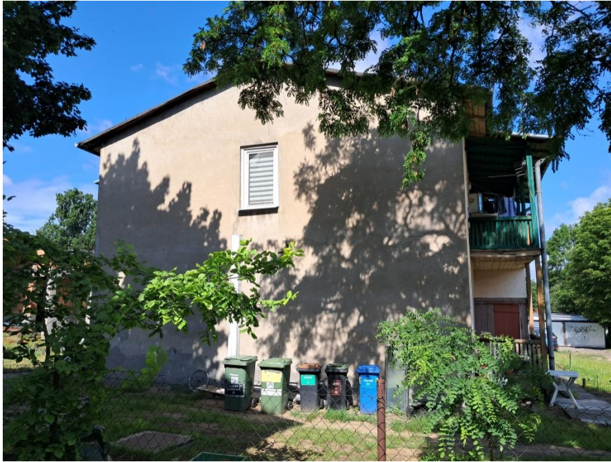
Zdjęcie 2 Elewacja boczna
