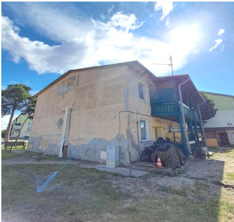
Zdjęcie 3 Elewacja boczna
