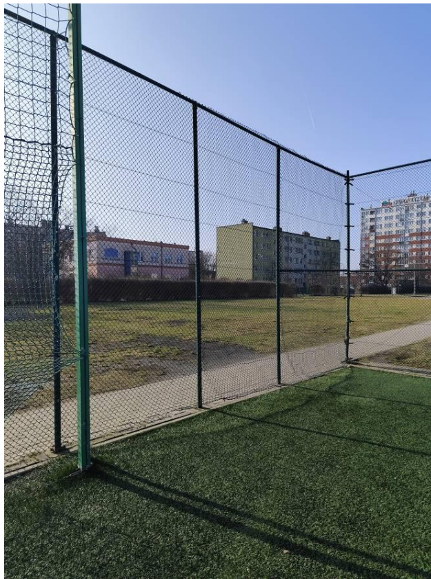
Siatka ogrodzeniowa do naprawy / wymiany
