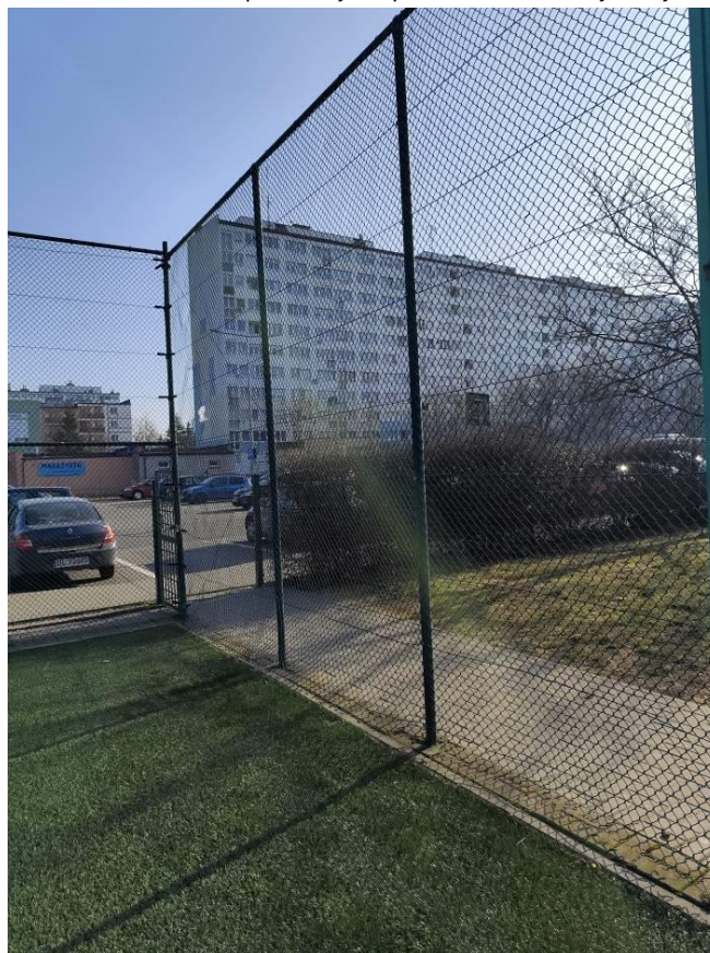
Lokalizacja furtki – południowe ogrodzenie boiska
