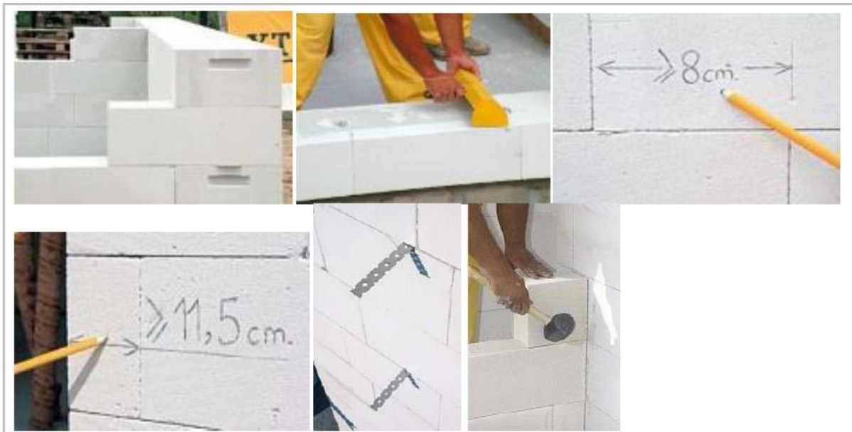
Rysunek 2.10 Murowanie z bloczków z betonu komórkowego
