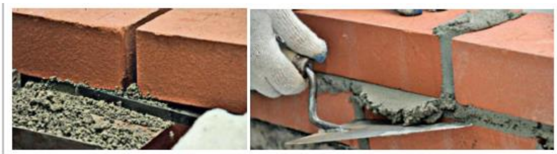
Rysunek 2.12 Murowanie na spoiny puste i pełne
