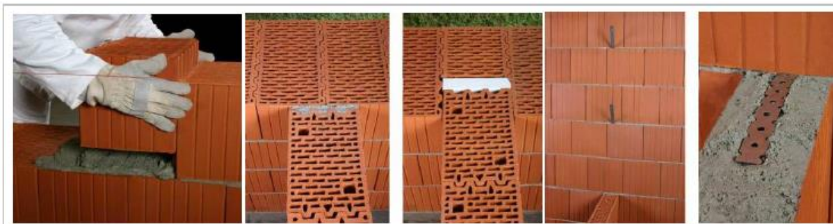
Rysunek 2.9 Murowanie z pustaków ceramicznych poryzowanych
