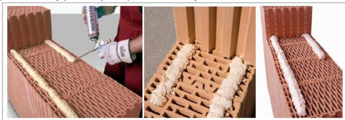
Rysunek 2.17 Murowanie na zaprawy murarskie w piance
