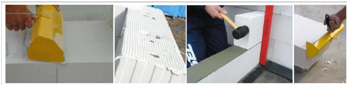
Rysunek 2.15 Murowanie na cienkie spoiny przy wykorzystaniu specjalnych narzędzi
